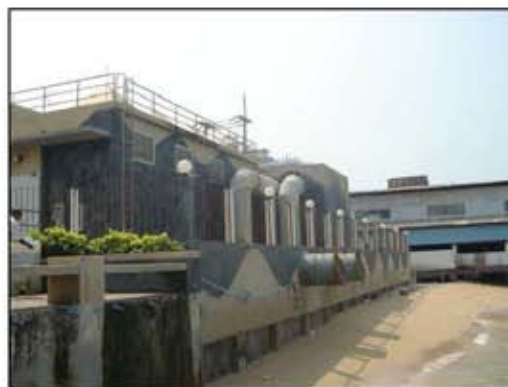
ภาพที่ 4.6 ท่อปล่อยน้ำด้านหลัง อาคารสูบน้ำบาดพิทยา
