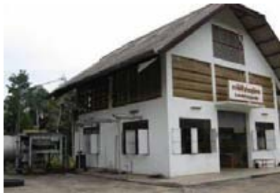
โรงปั่นไฟฟ้า
