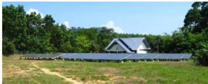
โรงไฟฟ้าพลังงานแสงอาทิตย์
