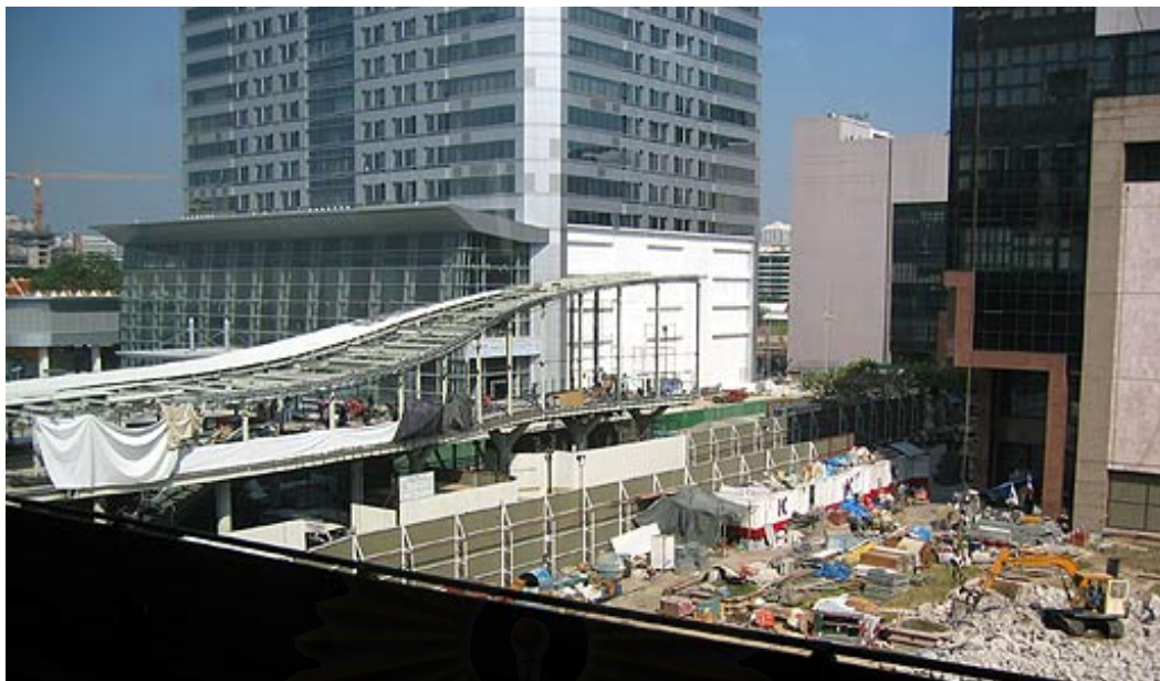
ภาพที่ 3-11 แสดงการก่อสร้างทางเชื่อมจากทางเดินลอยฟ้าเข้าเซ็นทรัลเวิร์ดที่ชั้น 2 พ.ศ.2547
