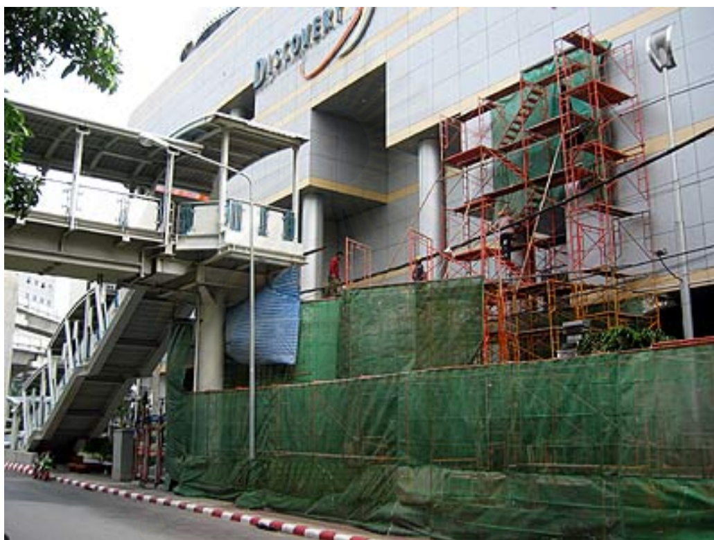
ภาพที่ 3-10 แสดงการก่อสร้างทางเชื่อมจากทางเดินลอยฟ้าเข้าสู่สยามดิสคัฟเวอรีที่ชั้น 3 พ.ศ.2546
