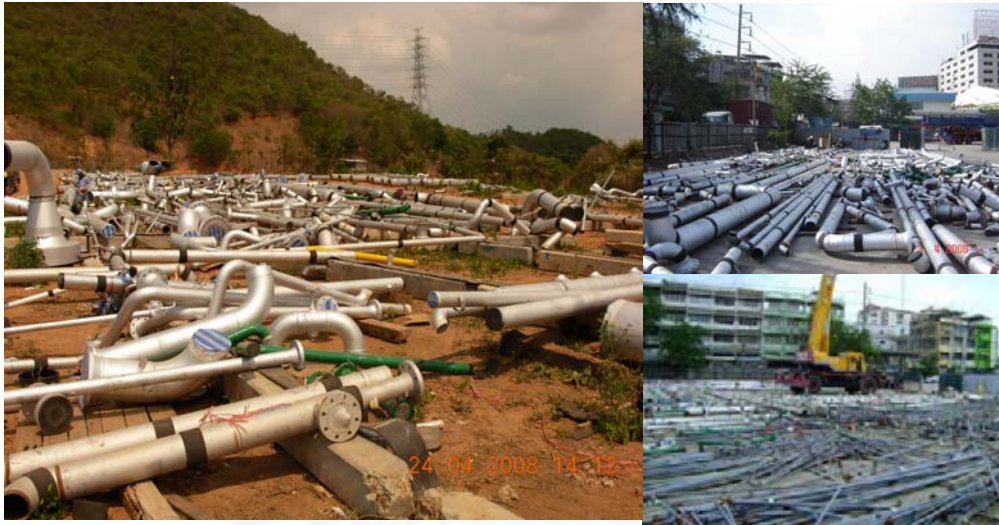
รูปที่ 3.10 สภาพพื้นที่จัดเก็บชิ้นงานท่อขึ้นรูปที่รอการติดตั้ง
