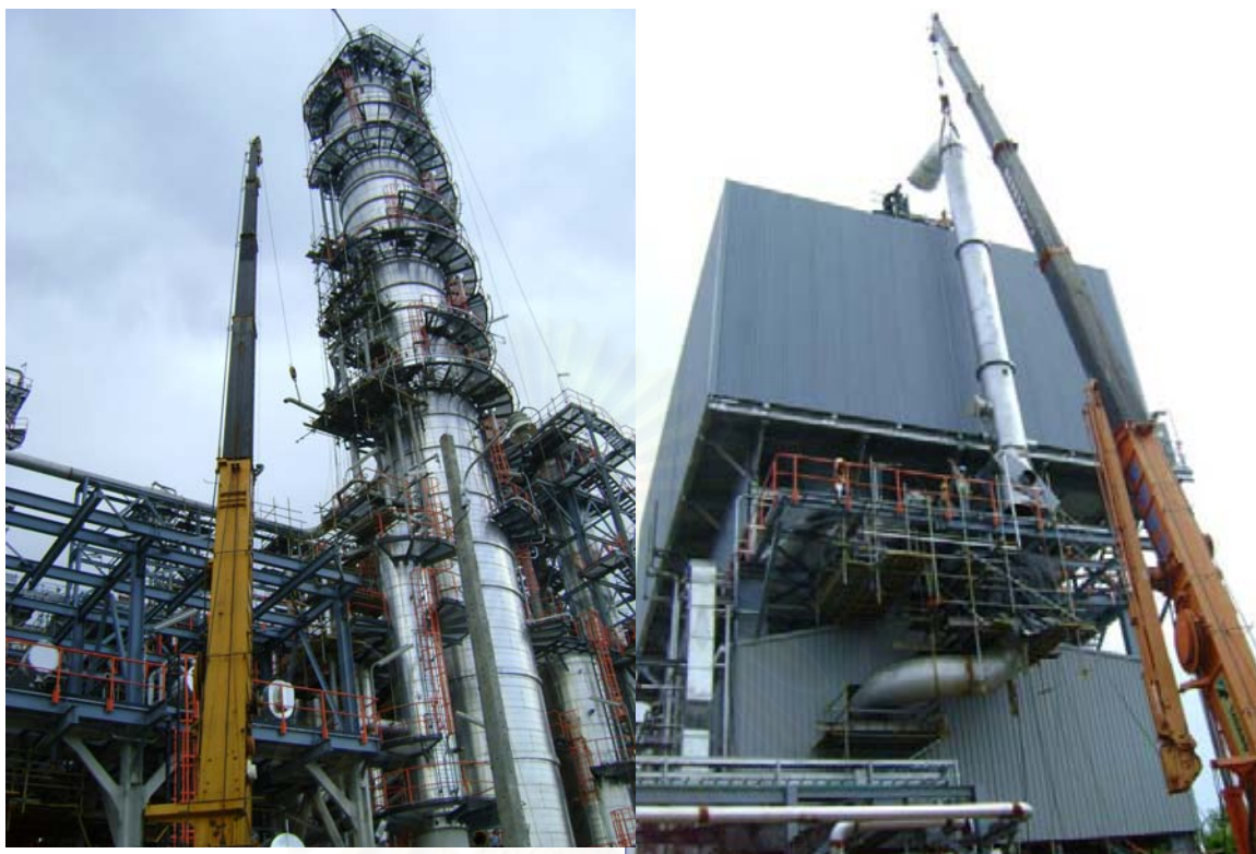
รูปที่ 3.12 การยกติดตั้งชิ้นงานท่อขึ้นรูปที่ผลิตเสร็จจากโรงงานเข้ากับวัสดุอุปกรณ์ที่หน้างาน
