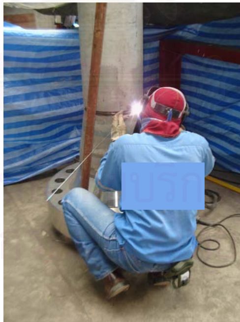
รูปที่ 3.9 การเชื่อมต่อโดยใช้ช่างฝีมือและอุปกรณ์เครื่องเชื่อมในการเชื่อม
