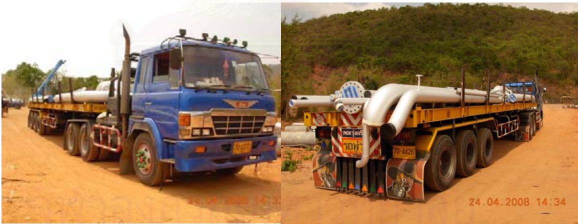
รูปที่ 3.11 การขนส่งชิ้นงานท่อขึ้นรูปไปยังพื้นที่จัดเก็บและพื้นที่ติดตั้ง
