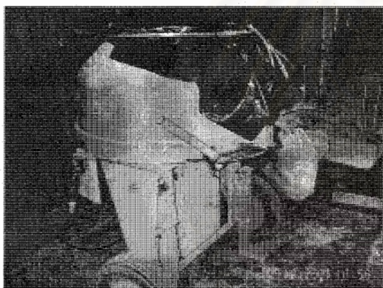
รูปที่ ค-20 แสดงการเตรียมวัสดุเคลือบผิวเหล็กโครงสร้างรูปพรรณป้องกันไฟแห้งโดยการผสมในโมไฟฟ้างัด
