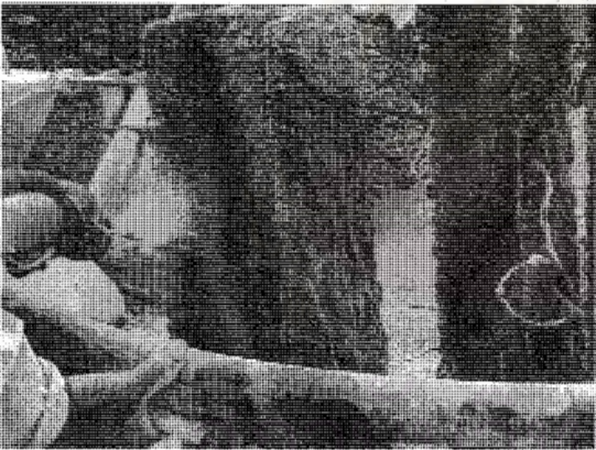
รูปที่ ค-29 แสดงการพ่นวัสดุเคลือบผิวเหล็กโครงสร้างรูปพรรณด้วยวัสดุเคลือบผิวป้องกันไฟในชั้นที่ 2
