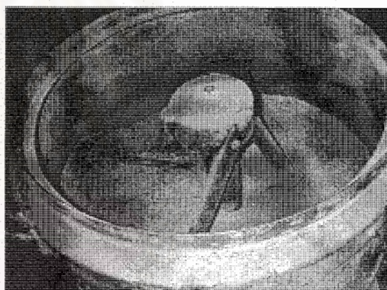
รูปที่ ค-20 แสดงการเตรียมวัสดุเคลือบผิวเหล็กโครงสร้างรูปพรรณป้องกันไฟแห้งโดยการผสมในโมไฟฟ้างัด
