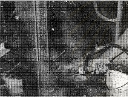
รูปที่ ค-25 แสดงการพ่นวัสดุเคลือบผิวเหล็กโครงสร้างรูปพรรณป้องกันไฟลงบนเหล็กรูปพรรณ
