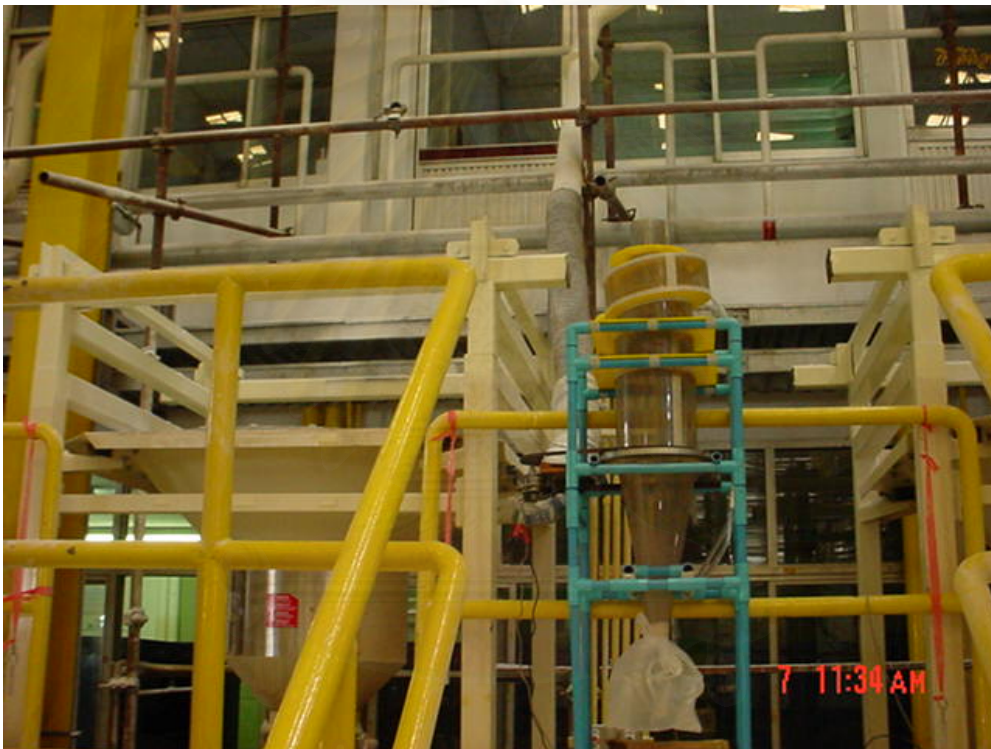
รูปที่ 4.1 การต่ออุปกรณ์เข้าสถานที่ทำการทดลองจริง
