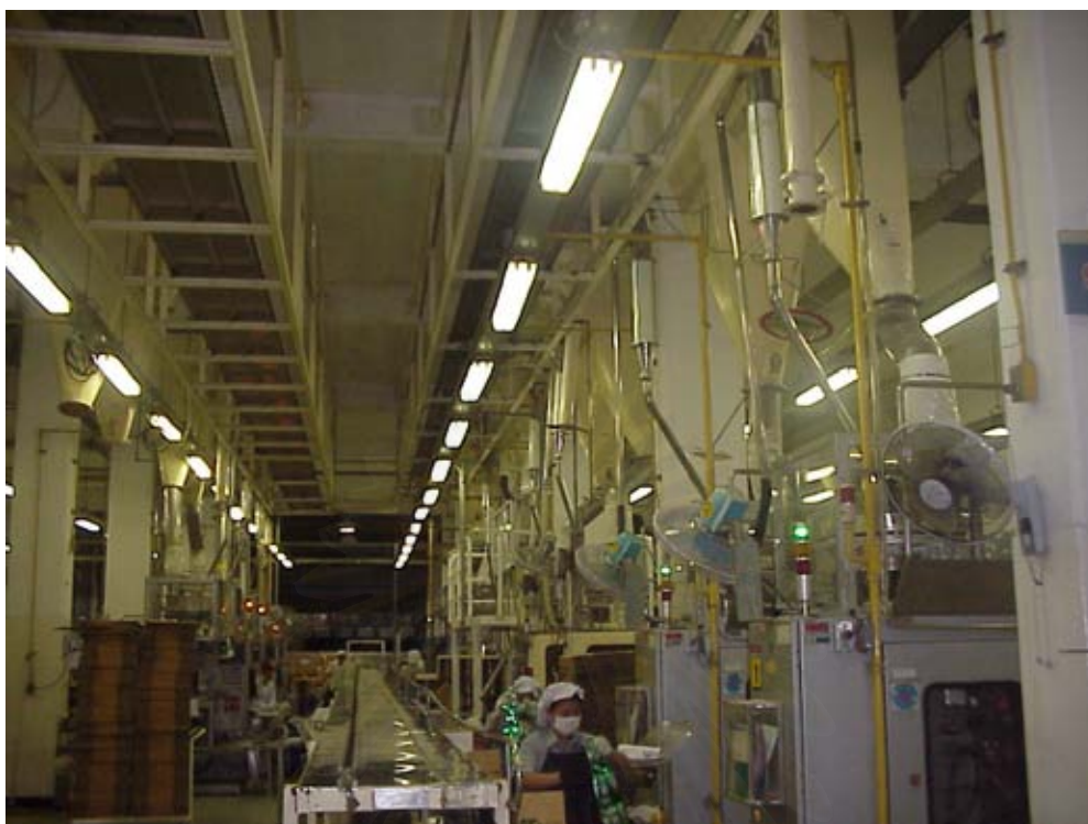
รูปที่ 1.6 บริเวณที่ติดตั้งไซโคลน แต่เป็นจุดที่เครื่องจักร Filling machine
