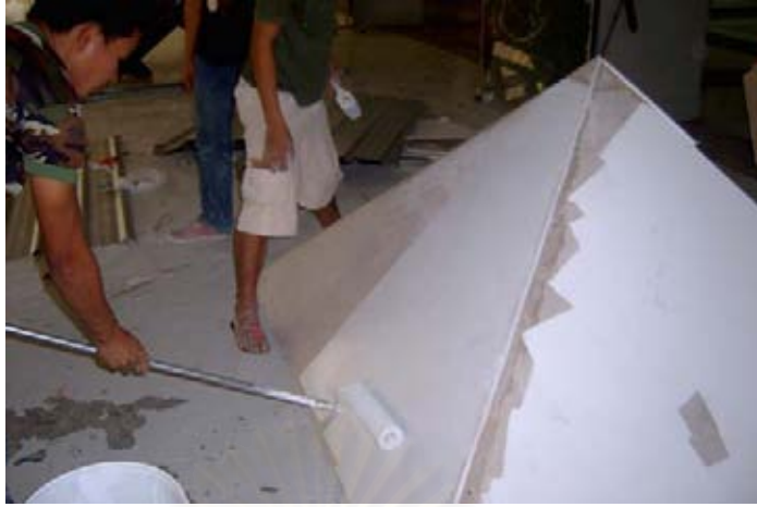
ภาพที่ 3.4 แสดงการประกอบรูปทรงปิระมิดผนังยิปซัมทาสี
