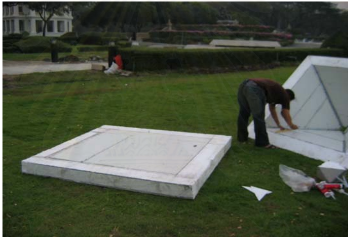
ภาพที่ 3.5 แสดงการประกอบรูปทรงปิระมิดผนังระบบฉนวน
