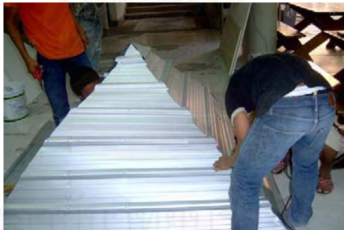
ภาพที่ 3.3 แสดงการประกอบรูปทรงปริมาตรผนังเหล็กเคลือบสังกะสี
