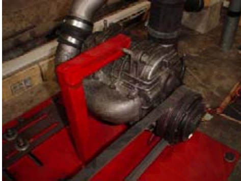
รูปที่ 4.28 การติดตั้งเครื่องอัดอากาศ
