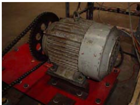
รูปที่ 4.26 การติดตั้งมอเตอร์ขับเคลื่อนเครื่องอัดอากาศ
