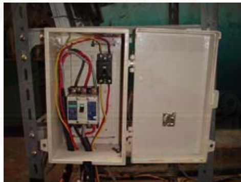
รูปที่ 4.35 แท่นควบคุม: ตู้สะพานไฟ
