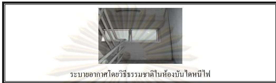
ภาพที่ 3.2.5 ระบบระบายอากาศ
