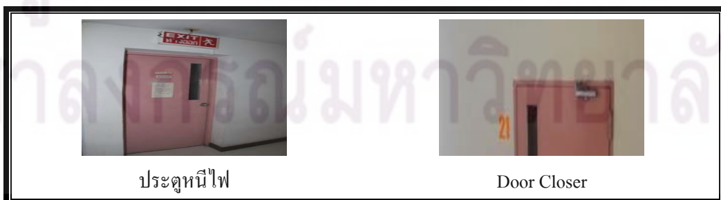
ภาพที่ 4.3.1 ระบบบันไดหนีไฟและทางหนีไฟ
