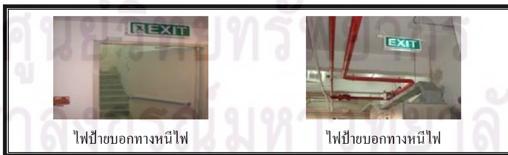
ภาพที่ 5.3.2 เครื่องหมายและไฟป้ายบอกทางออกฉุกเฉิน
