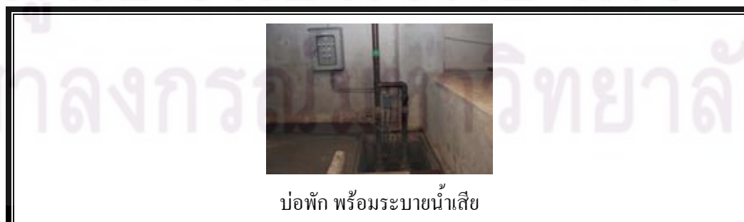
ภาพที่ 4.2.2 ระบบระบายน้ำเสียและระบบบำบัดน้ำเสีย
