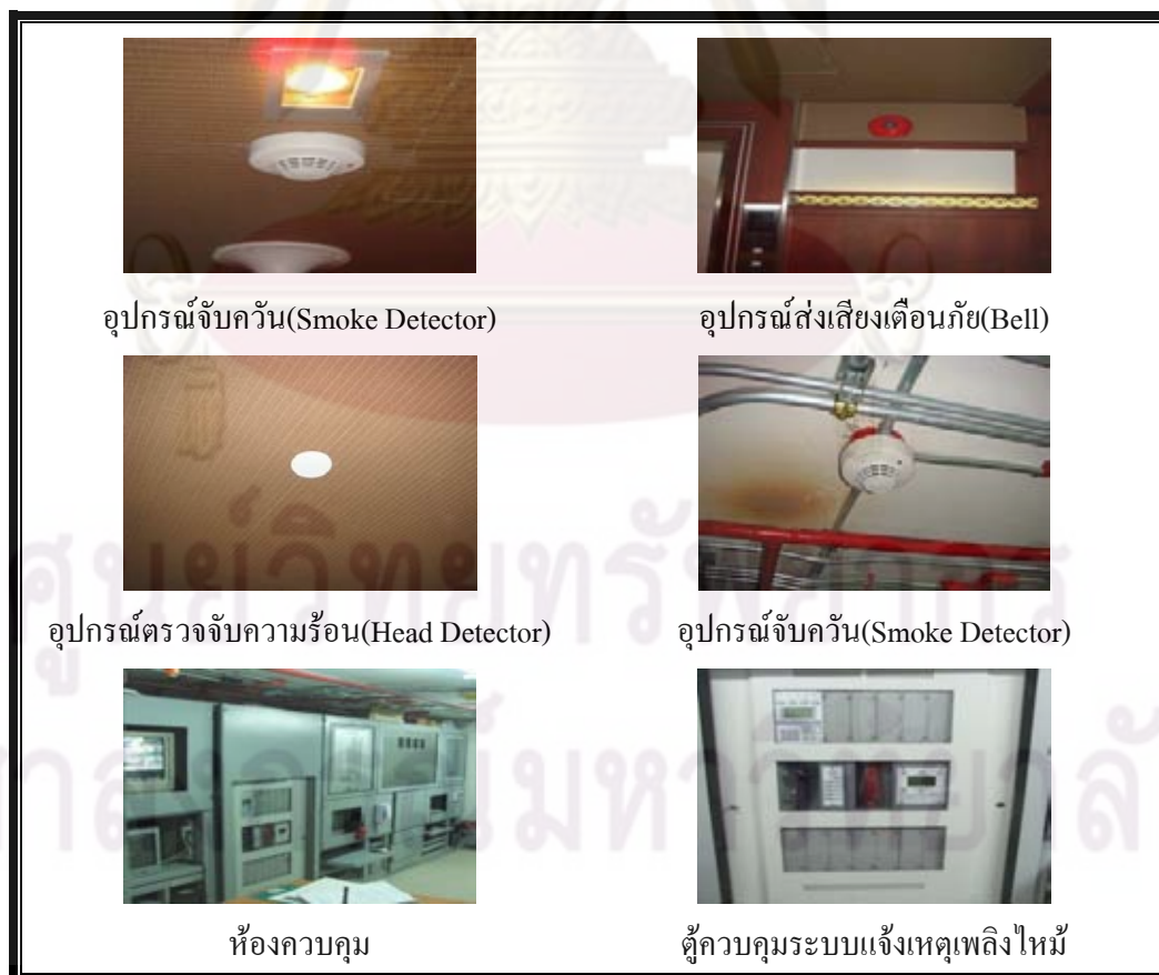
ภาพที่ 5.3.6 ระบบสัญญาณแจ้งเหตุเพลิงไหม้
