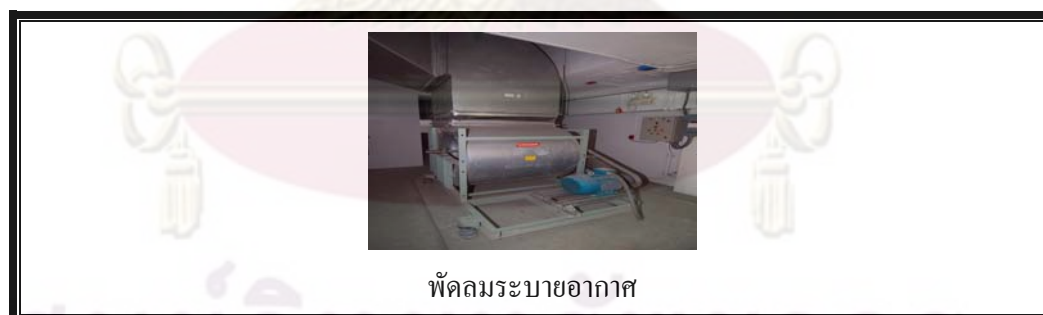
ภาพที่ 7.2.5 ระบบระบายอากาศ
