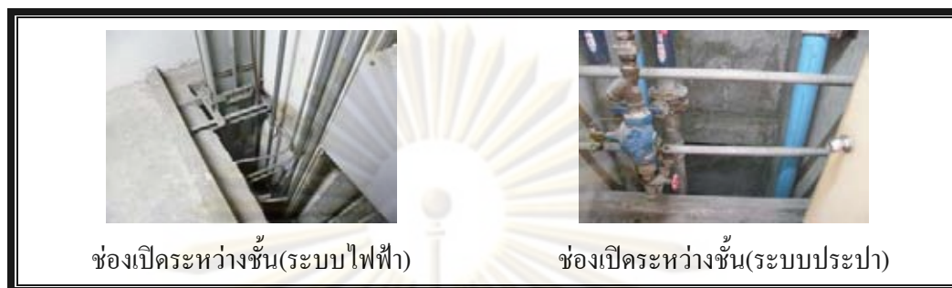
ภาพที่ 2.3.3 ระบบระบายควันและควบคุมการแพร่กระจายควัน
