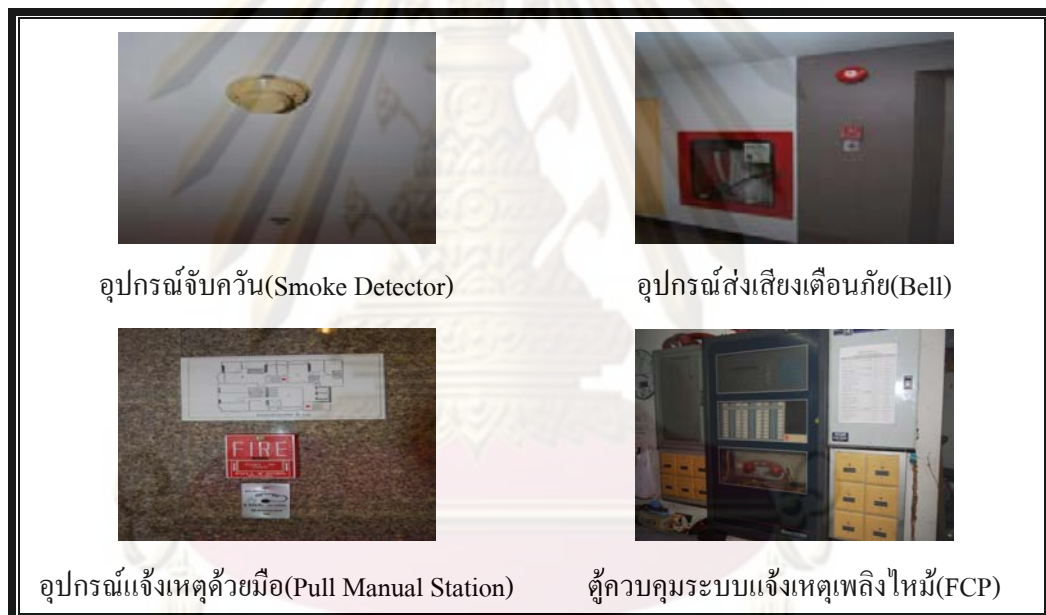
ภาพที่ 1.3.6 ระบบสัญญาณแจ้งเหตุเพลิงไหม้
