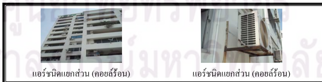
ภาพที่ 3.1.3 ระบบปรับอากาศ
