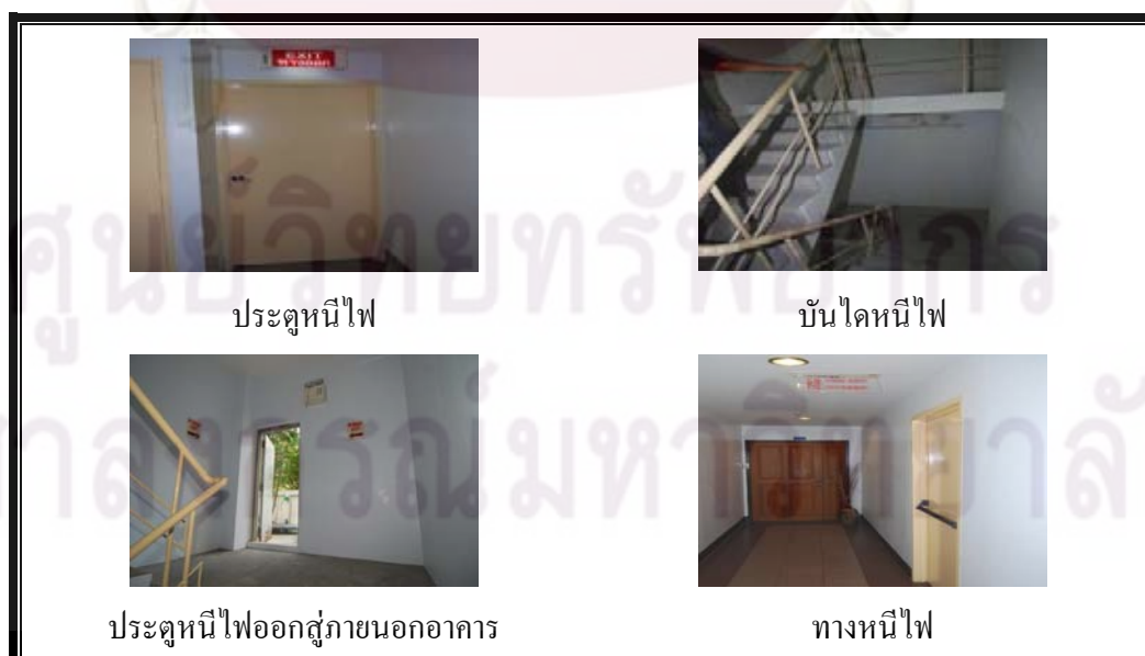
ภาพที่ 1.3.1 ระบบบันไดหนีไฟและทางหนีไฟ
