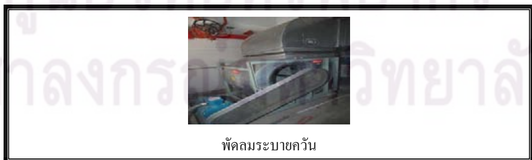
ภาพที่ 7.3.3 ระบบระบายควันและควบคุมการแพร่กระจายควัน
