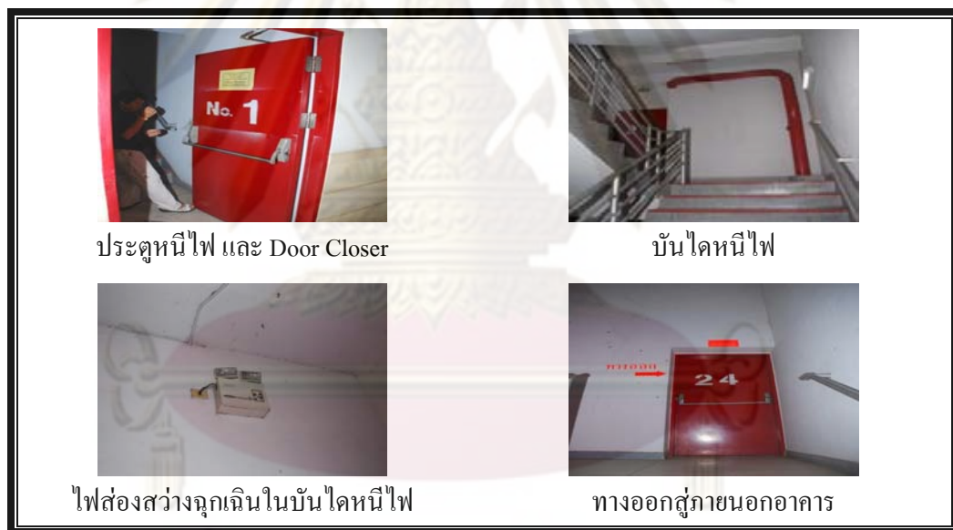
ภาพที่ 2.3.1 ระบบบันไดหนีไฟและทางหนีไฟ
