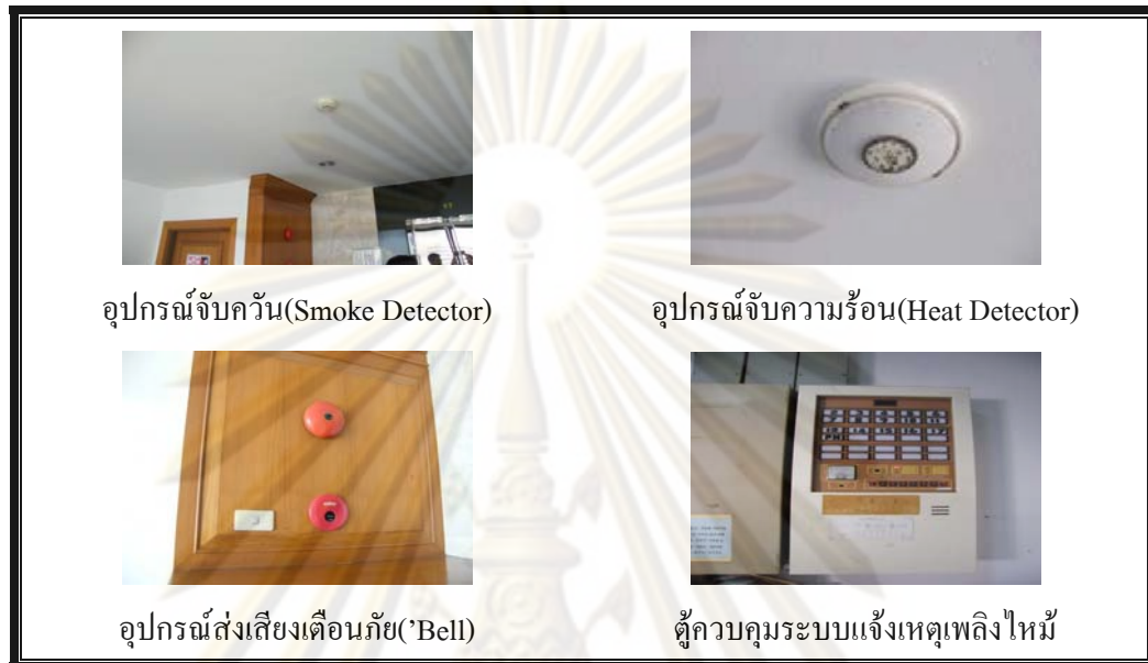
ภาพที่ 8.3.5 ระบบสัญญาณแจ้งเหตุเพลิงไหม้
