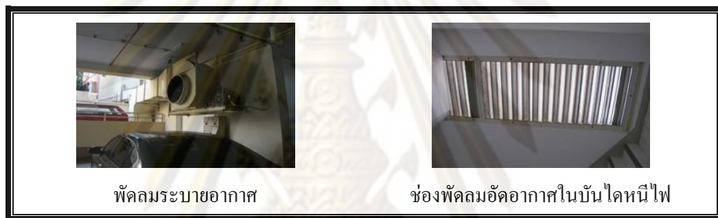
ภาพที่ 6.2.5 ระบบระบายอากาศ
