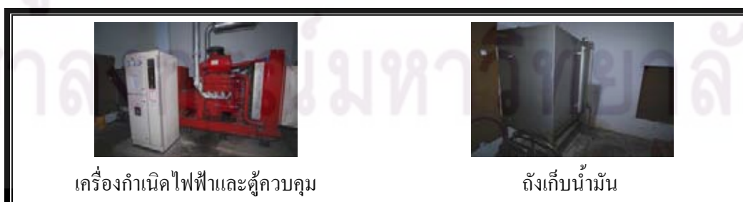
ภาพที่ 1.3.4 ระบบไฟฟ้าสำรองฉุกเฉิน
