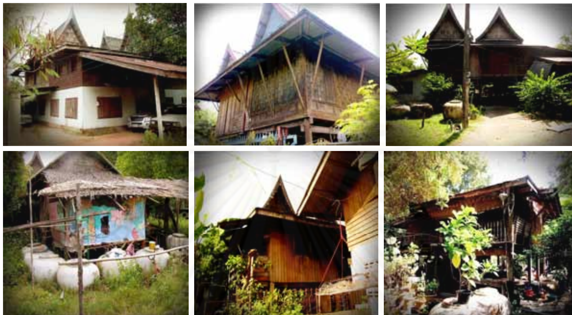
รูปที่1-6 : แสดงสถาปัตยกรรมชนเขายี่สารในปัจจุบัน
