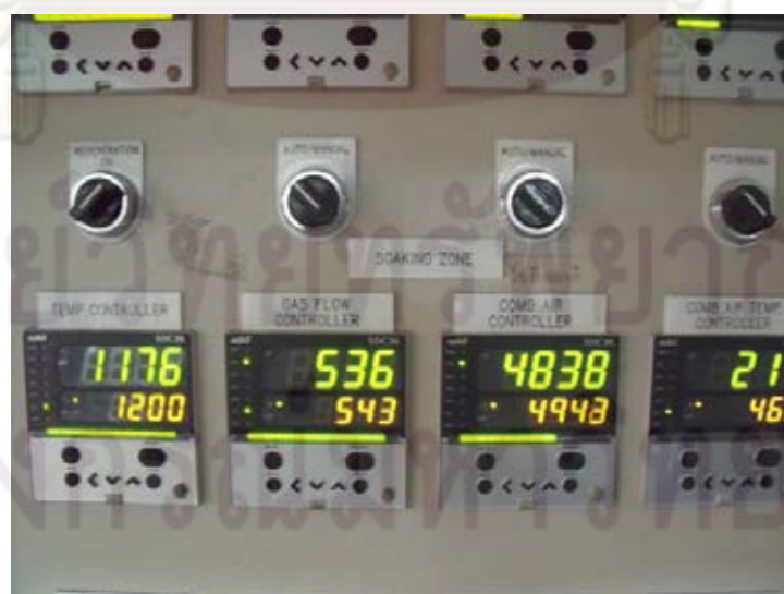
รูปที่ 4.20 จอแสดงอุณหภูมิอากาศหลังจากการ preheat ที่รีคูเพอเรเตอร์ (จอขวาสุด)
