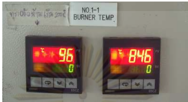
รูปที่ 4.18 จอแสดงอุณหภูมิอากาศภายนอกเข้าหัวเผาจีเจนเนอเรทีฟ (รูปซ้าย)
