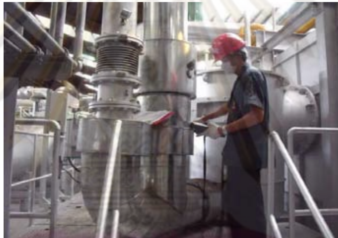
รูปที่ 4.16 การวัดไอเสียที่ออกจากหัวเผาจีเจนเนอเรทีฟ
