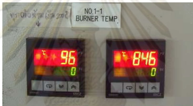
รูปที่ 4.19 จอแสดงอุณหภูมิอากาศ preheat ก่อนเข้าหัวเผาจีเจนเนอเรทีฟ (รูปขวา)
