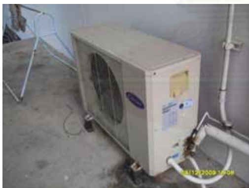
ภาพที่ 4.3 เครื่องปรับอากาศชนิด Split Type ที่ใช้ในอาคารกรณีศึกษา
