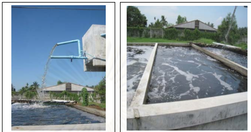
ภาพที่ 3.3 บ่อพักน้ำทิ้งที่ผ่านระบบบำบัดน้ำเสียแบบไร้อากาศ
