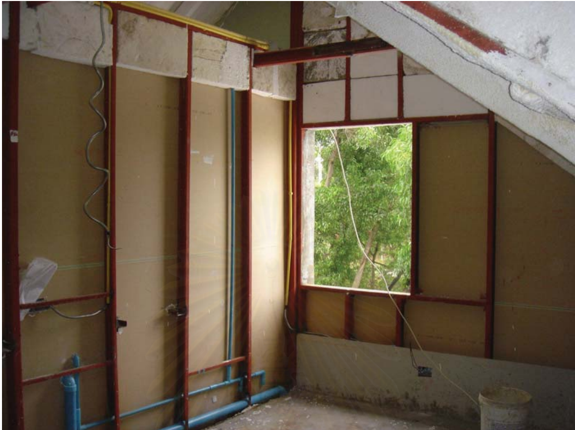
รูปที่ 6-5 การเตรียมช่องเปิดก่อนการติดตั้ง
