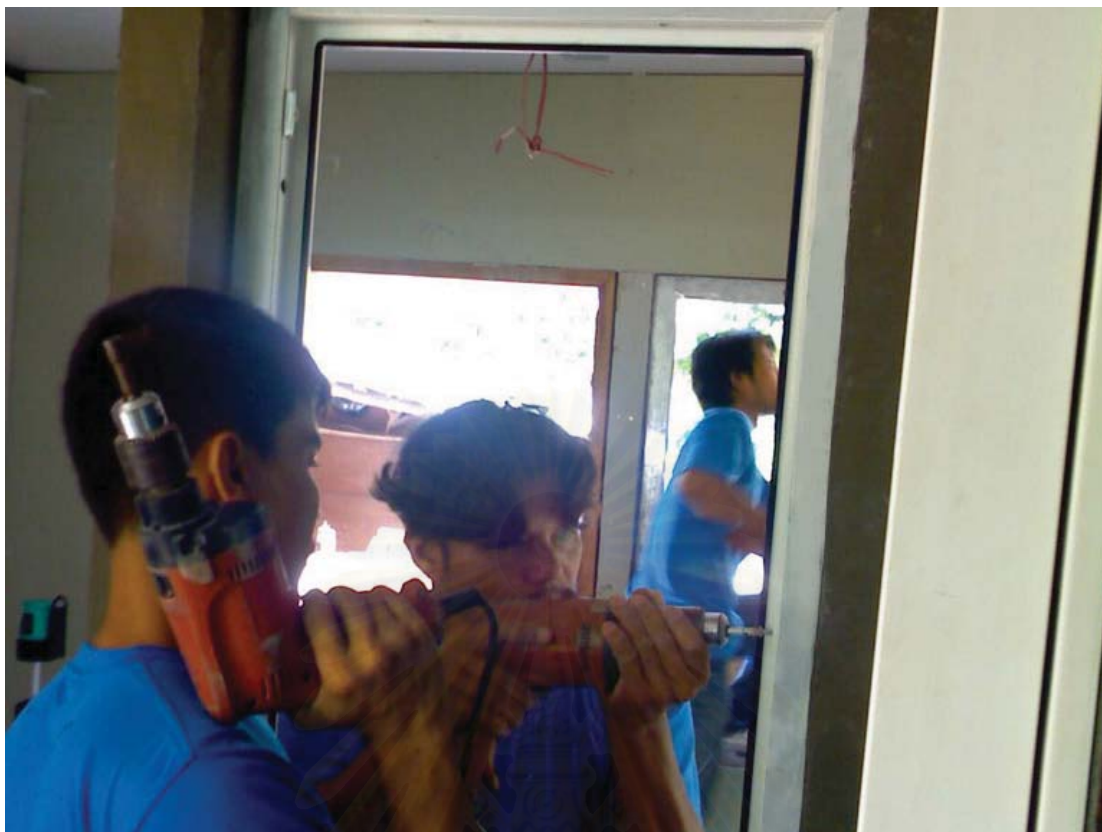
รูปที่ 6-7 การติดตั้งช่องเปิด
