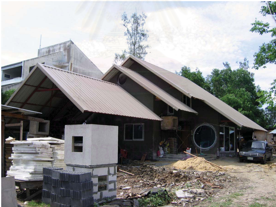
รูปที่ 6-4 อาคารบ้านชีวาทิตย์ 2
