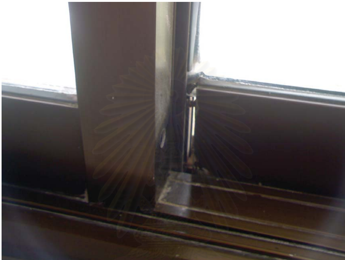
ภาพที่ 2-5 แสดงปัญหาการรั่วซึมอากาศบริเวณรอยต่อของบานกรอบอลูมิเนียม
