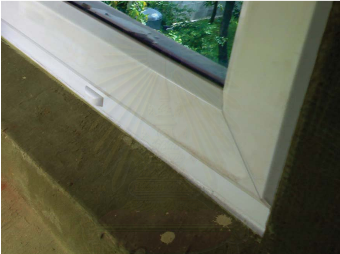
ภาพที่ 2-6 แสดงรอยต่อของบานกรอบยูพีวีซี
