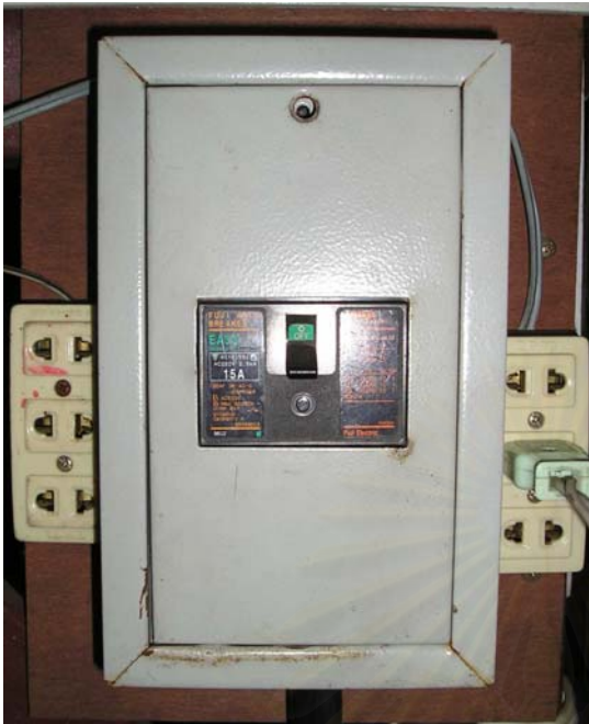
ก) การติดตั้งสวิตช์ควบคุม
