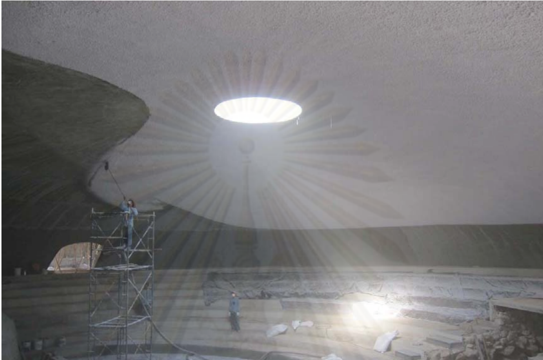
ภาพที่ 5-28 แสดงการติดตั้งฝ้าเพดานเซลลูโลสเพื่อดูดซับเสียง
