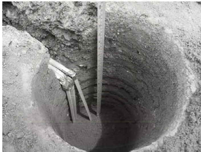
รูปที่ 3.11 การฝังหัววัดความชื้นและบดอัดดินในโครงสร้างทาง
