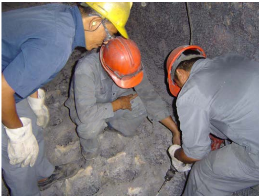
รูปที่ 5.4 การเจาะวัสดุสะสมความร้อนด้านบนเพื่อติดตั้งเทอร์โมคัปเปิ้ล
