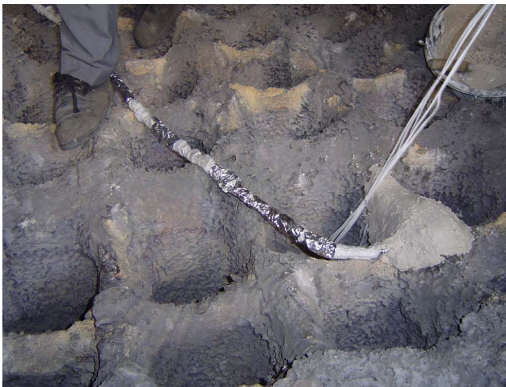
รูปที่ 5.6 การหุ้มสายเทอร์โมคัปเปิลด้วยเซรามิกไฟเบอร์หลังจากการติดตั้งเทอร์โมคัปเปิล เพื่อกันความร้อนเนื่องจากด้านบนของ Regenerator มีความร้อนสูงมากกว่า 700^{\circ}\text{C}
