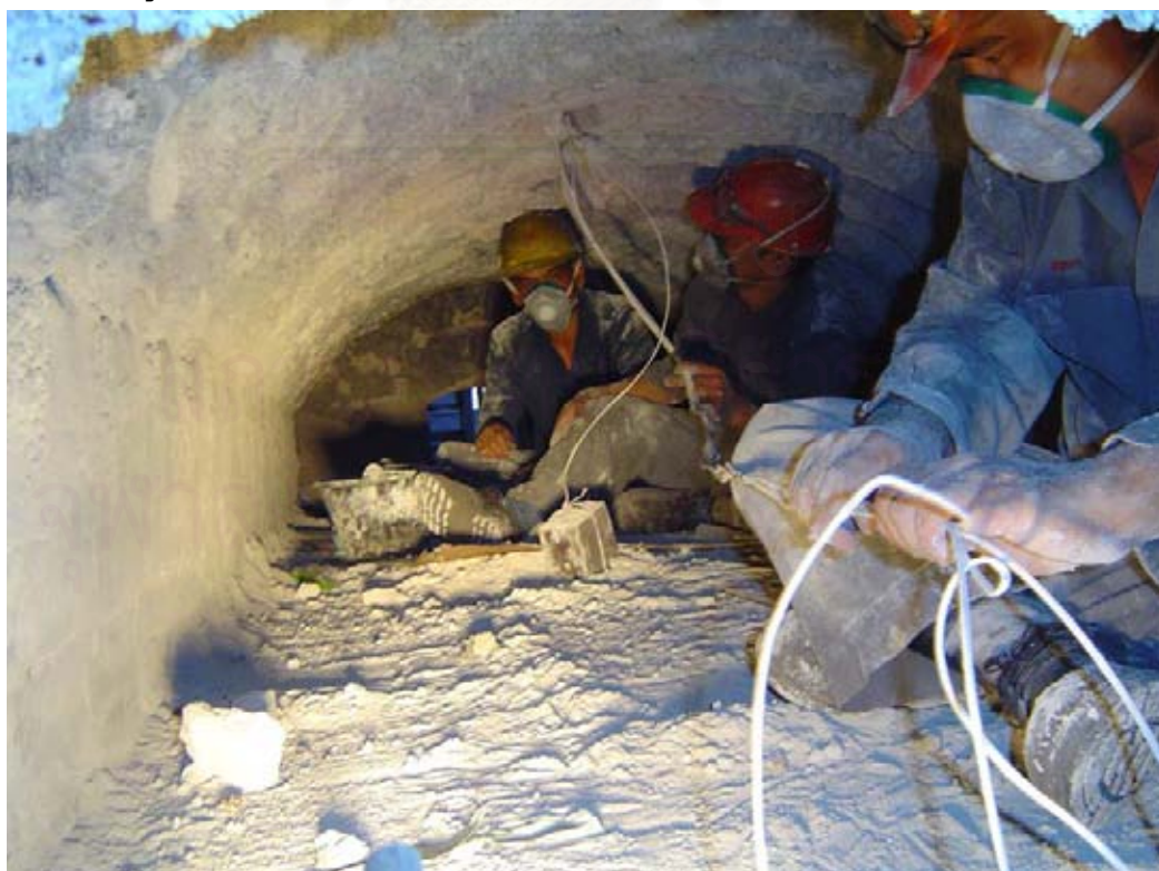
รูปที่ 5.5 การเจาะวัสดุสะสมความร้อนด้านล่างเพื่อติดตั้งเทอร์โมคัปเปิ้ล
