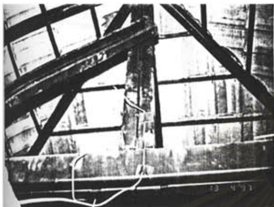
(10) การวัดอุณหภูมิอากาศภายในหลังคา
