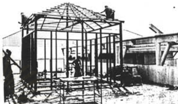
(2) การทำโครงหลังคาเหล็ก
