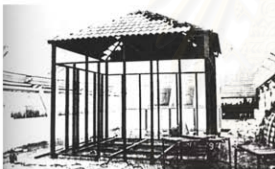
(3) การปูกระเบื้องหลังคาคอนกรีต ซีแพคโมเนีย สีอิฐอำไพ
