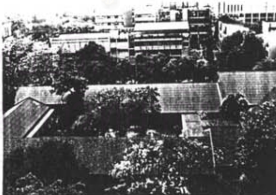
(22) หลังคากระเบื้องซีแพคโมเนีย และกระเบื้องลอนคู่ อาคารคณะวิศวกรรมศาสตร์
