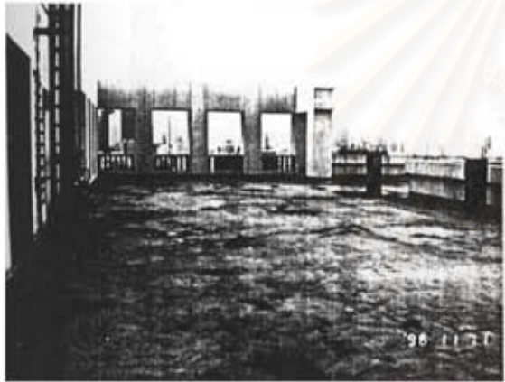
(3) หลังคาอนกริตเสริมเหล็ก อาคารบรมราชกุมารี
