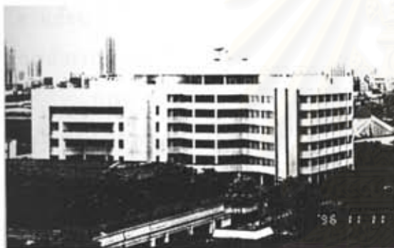
(19) หลังคาคอนกรีตเสริมเหล็ก อาคารวิทยบริการ
