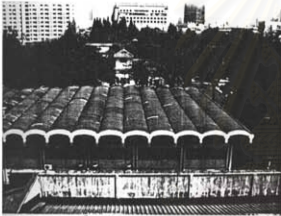
(14) หลังคากระเบื้องลอนคู่ โครงอาหารโรงพิมพ์
