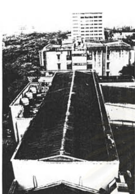
(7) หลังคากระเบื้องลอนคู่ อาคารคณะศิลปกรรมศาสตร์
