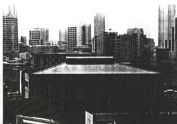
(18) หลังคากระเบื้องลอนคู่ อาคารโรงเรียนสาธิตจามจุย
