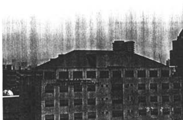
(11) หลังคากระเบื้องลอนคู่ อาคารพิพิธภัณฑ์เทคโนโลยีทางภาพ
