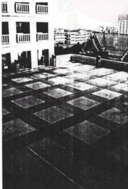
(5) หลังคาอนกริตเสริมเหล็ก ปูด้วยกรวดล้าง อาคารบรมราชกุมารี
