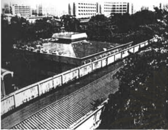
(12) หลังคากระเบื้องลอนคู่ อาคารจามจุรี 1 และอาคารทรัพย์สิน
