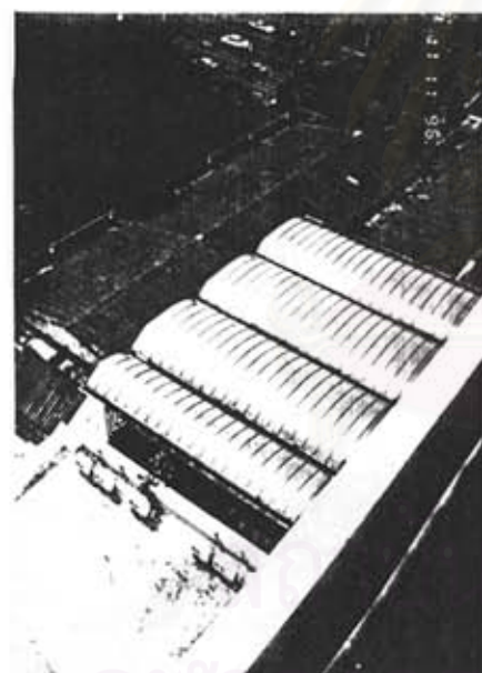
(9) หลังคา Skylight อาคารคณะสถาปัตยกรรมศาสตร์
