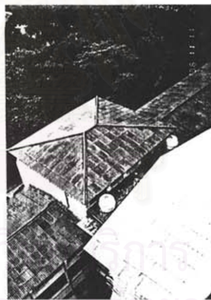
(10) หลังคากระเบื้องลอนคู่ อาคารคณะสถาปัตยกรรมศาสตร์
