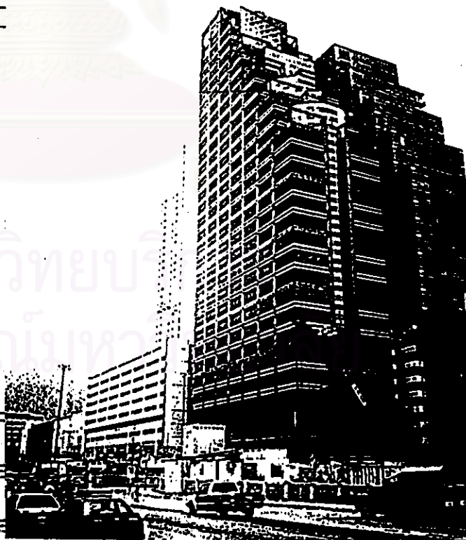
สภาพโครงการในปัจจุบันปี 2539
