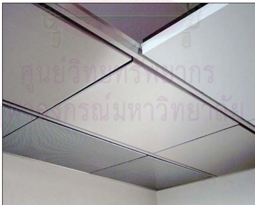
รูปที่ 3.13 การวางแผ่นฝ้าเพดานจากฟางข้าวผสมกับมะพร้าวสับบนฝ้า T-Bar ขนาด 60x60 ซม.
