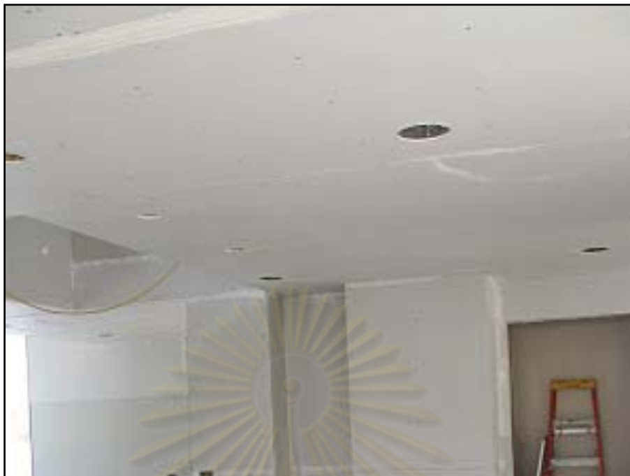
รูปที่ 3.14 การเจาะแผ่นฝ้าเพดานจากฟางข้าวผสมกับมะพร้าวสับ เพื่อติดบน โครงสร้างฝ้าเพดาน ขนาด 60x60 ซม.
