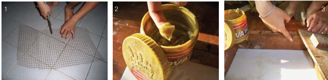
รูปที่ 3.7 ขั้นตอนกันเตรียมลวดตาไก่และบล็อกไม้แบบ
