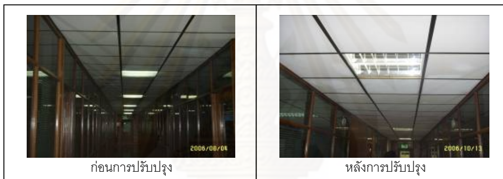
รูปที่ 5.5 สภาพก่อนปรับปรุงและหลังปรับปรุงของมาตรการที่ 5
