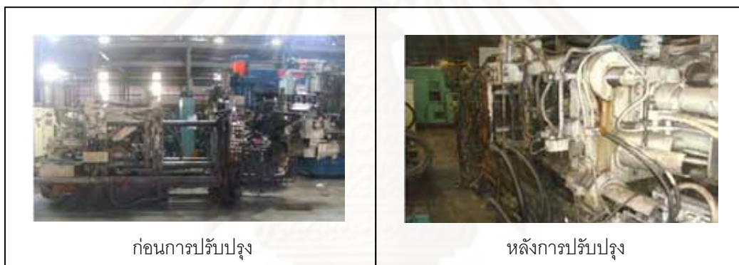
รูปที่ 5.2 สภาพก่อนปรับปรุงและหลังปรับปรุงของมาตรการที่ 2
