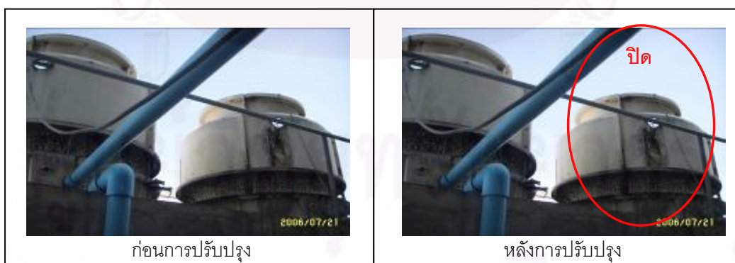
รูปที่ 5.3 สภาพก่อนปรับปรุงและหลังปรับปรุงของมาตรการที่ 3
