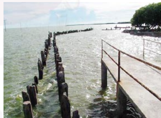
รูปที่ 2.7 เขื่อนสลายกำลังคลื่น ช่วยลดความรุนแรงของคลื่นและสะสมมวลตะกอน
