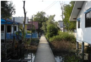
ทางเชื่อมต่อระหว่างซอย 8-11 ไม่ติดตั้งไฟส่องสว่างและไม่มีราวจับตามทางเดิน
