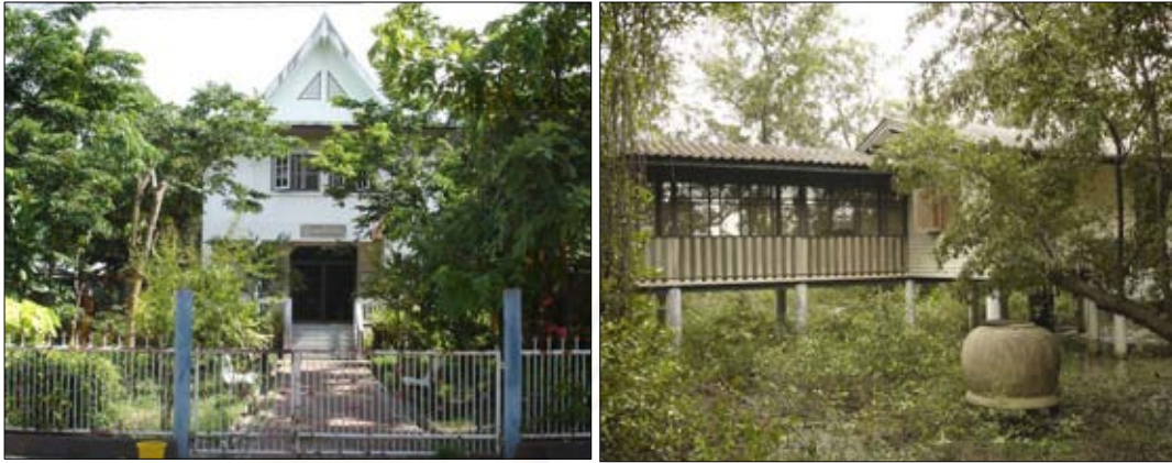
รูปที่ 4.20-4.21 (ซ้าย): ภูมิที่ตั้งอยู่บนพื้นที่ปรับถม เป็นอาคารคอนกรีตมีแนวกันรั้วแบ่งขอบเขต และ (ขวา) ภูมิที่ตั้งอยู่ในพื้นที่ป่าชายเลน เป็นอาคารไม้แบบเก่า มีโถงเดินยาว สำหรับเดินจูงลม ดัดมุ้งลวด
