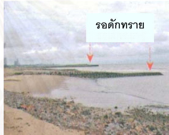
รูปที่ 2.5 รอดักทราย กำแพงกันคลื่นสำหรับลดแรงปะทะแนวของกำแพงที่อยู่ในทิศทางเดียวกับลมและคลื่น
