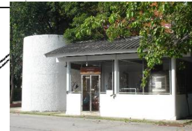
แทงก์น้ำหลัก โรงกรองน้ำและเครื่องสูบน้ำ จ่ายน้ำให้แทงก์ย่อยทั้งหมดภายในวัด
