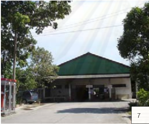
โรงครัวอยู่ในตำแหน่งที่มองเห็นได้จากทางเข้าหลัก มีลักษณะทางสถาปัตยกรรมที่ไม่สวยงาม
