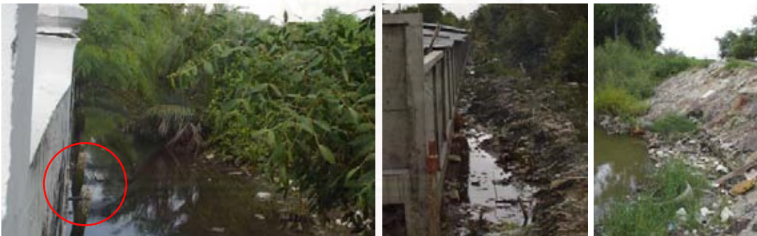
รูปที่ 4.52-4.54 (ซ้าย): น้ำทิ้งจากโรงครัวและห้องน้ำ (กลาง): และ (ขวา): คลองระบายน้ำที่ไหลผ่านท่อบริเวณแนวเขื่อนมีขยะอุดตัน
