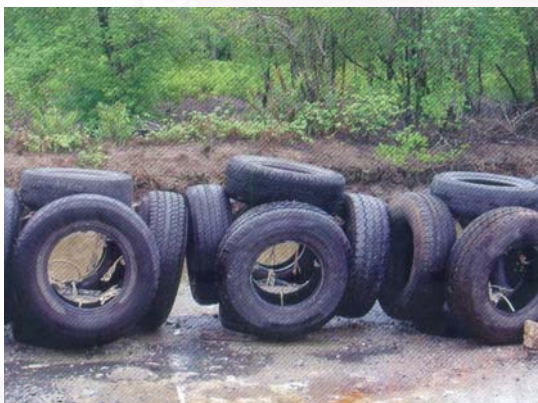
รูปที่ 2.6 การใช้เต้ายางช่วยลดแรงปะทะจากคลื่นและเพิ่มการสะสมมวลตะกอน
