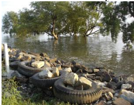
หินบรรจุในล้อรถวางหน้าเชื่อมป้องกัน การกัดเซาะจากคลื่นที่มากกระทบชายฝั่ง
