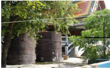
แทงก์น้ำเดิมใช้เก็บน้ำฝน ปัจจุบันใช้เก็บน้ำประปาสำหรับศาลาการเปรียญและห้องน้ำ
