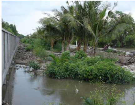
หลังขยายขนาดของระบบระบายน้ำ ช่วยให้ระบบไหลเวียนของน้ำดีขึ้นบางส่วน
