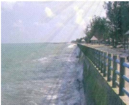
รูปที่ 2.4 กำแพงกันคลื่นแบบแนวตั้งบริเวณชายฝั่งสร้างเพื่อป้องกันการพังทลายของชายฝั่งที่ลาดชัน
