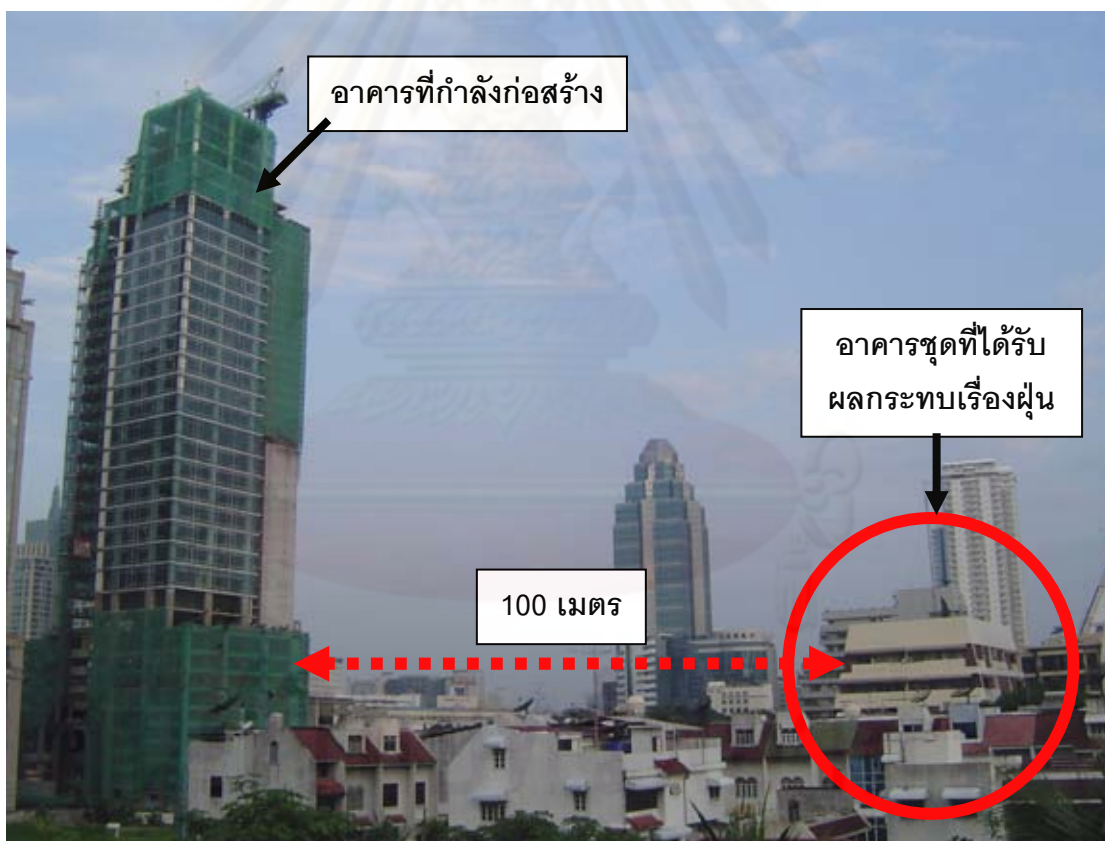
ภาพที่ 5-11 แสดงตำแหน่งอาคารชุดที่ได้รับผลกระทบเรื่องฝุ่นจากอาคารที่กำลังก่อสร้าง
