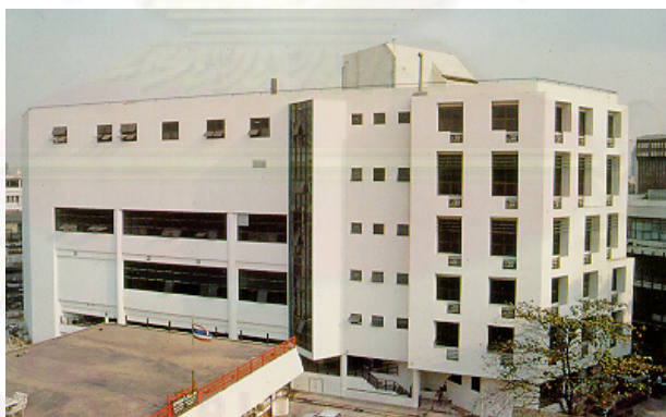
รูปที่ 2.3 โรงควบคุมคุณภาพน้ำสีพระยา
