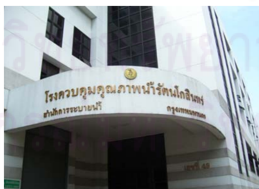
รูปที่ 2.5 โรงควบคุมคุณภาพน้ำรัตนโกสินทร์
