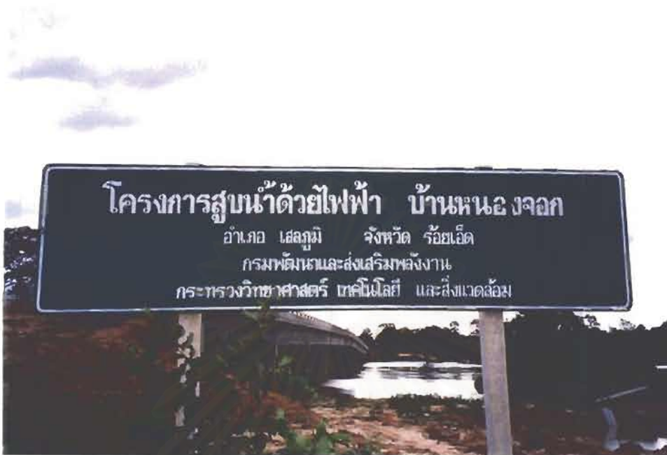
ภาพที่ 4.7.4 สถานีสูบน้ำบ้านหนองจอก อำเภอเสลภูมิ จังหวัดร้อยเอ็ด
