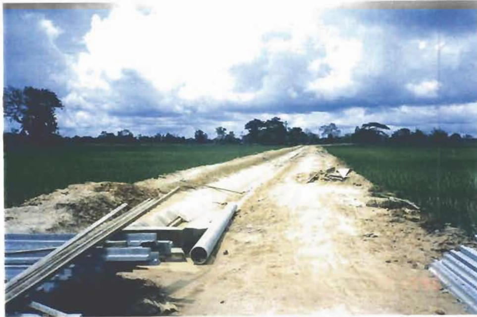
ภาพที่ 2.6 การก่อสร้างคลองสายประธาน (ตาดคอนกรีต)
