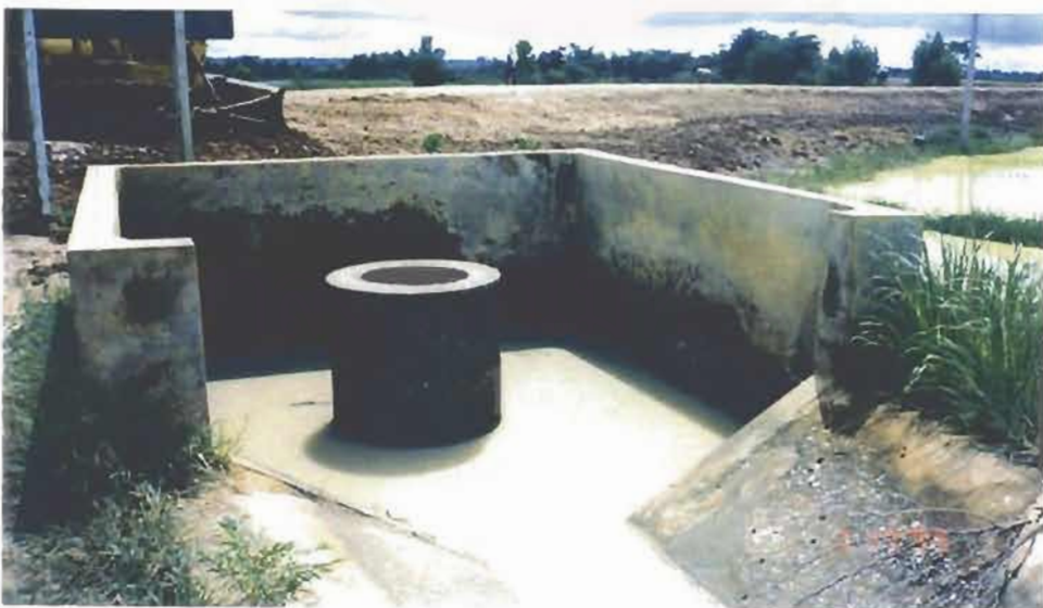
ภาพที่ 2.3 ลักษณะการส่งน้ำผ่านท่อส่งน้ำรับแรงดันไปยังบ่อพัก
