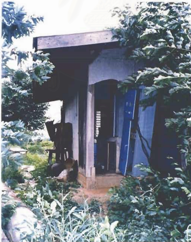
ภาพที่ 2.9 อาคารควบคุมระบบไฟฟ้า
