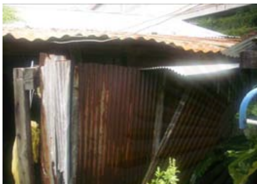
รูปบ้านก่อนปรับปรุง
