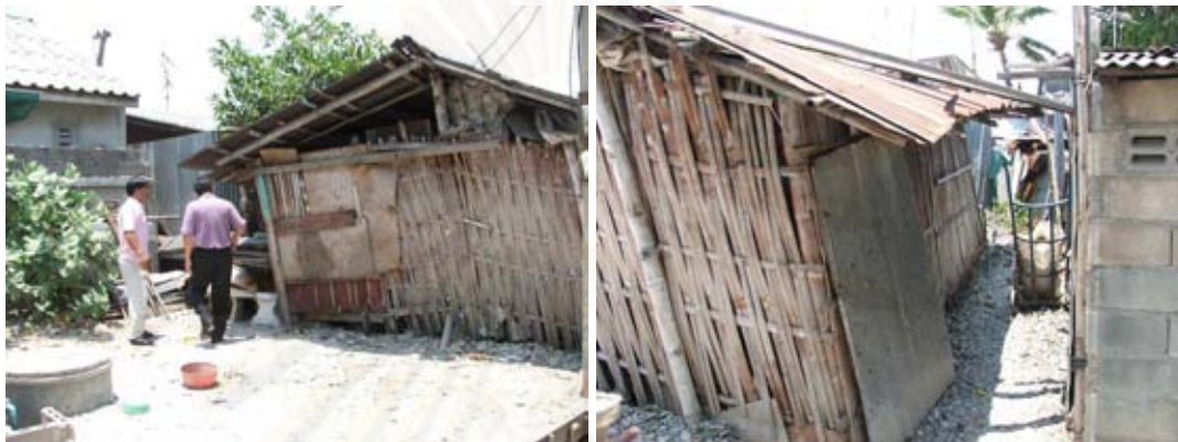
รูปบ้านก่อนดำเนินการ
