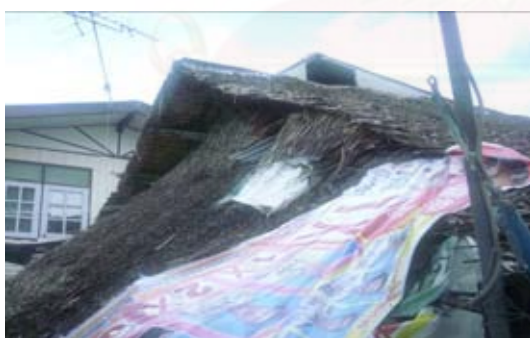
รูปบ้านก่อนปรับปรุง
