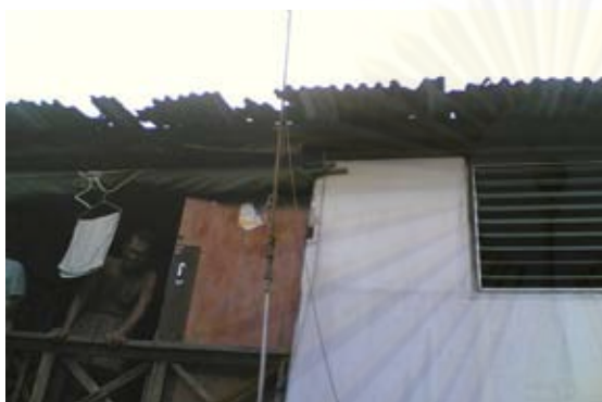
รูปบ้านก่อนปรับปรุง
