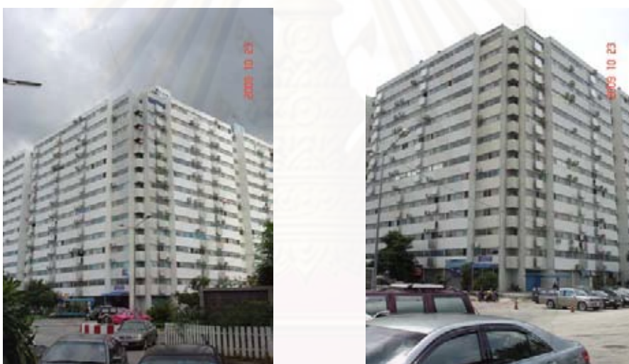
ภาพที่ 5.5 แสดงลักษณะทางกายภาพภายนอกอาคารสวัสดิการ T13 และ T14
