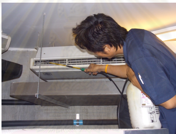
รูปที่ 4.10 การตรวจสอบและทำความสะอาดคอยล์เย็น
