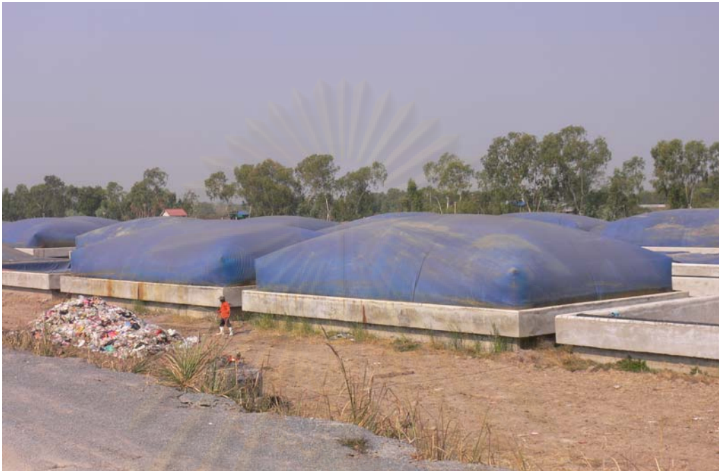
รูปที่ 4.4 บ่อหมักขยะ ขนาด 12x8x3.50 เมตร
