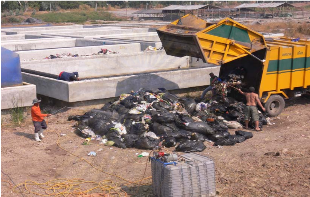
รูปที่ 4.6 บ่อหมักขยะ ขนาด 12x8x3.50 เมตร
