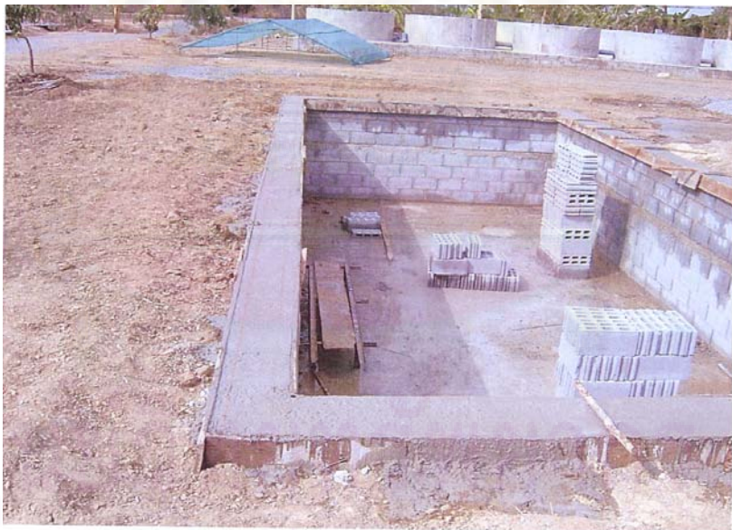
รูปที่ 3.3 การเทพื้นทับหลัง
