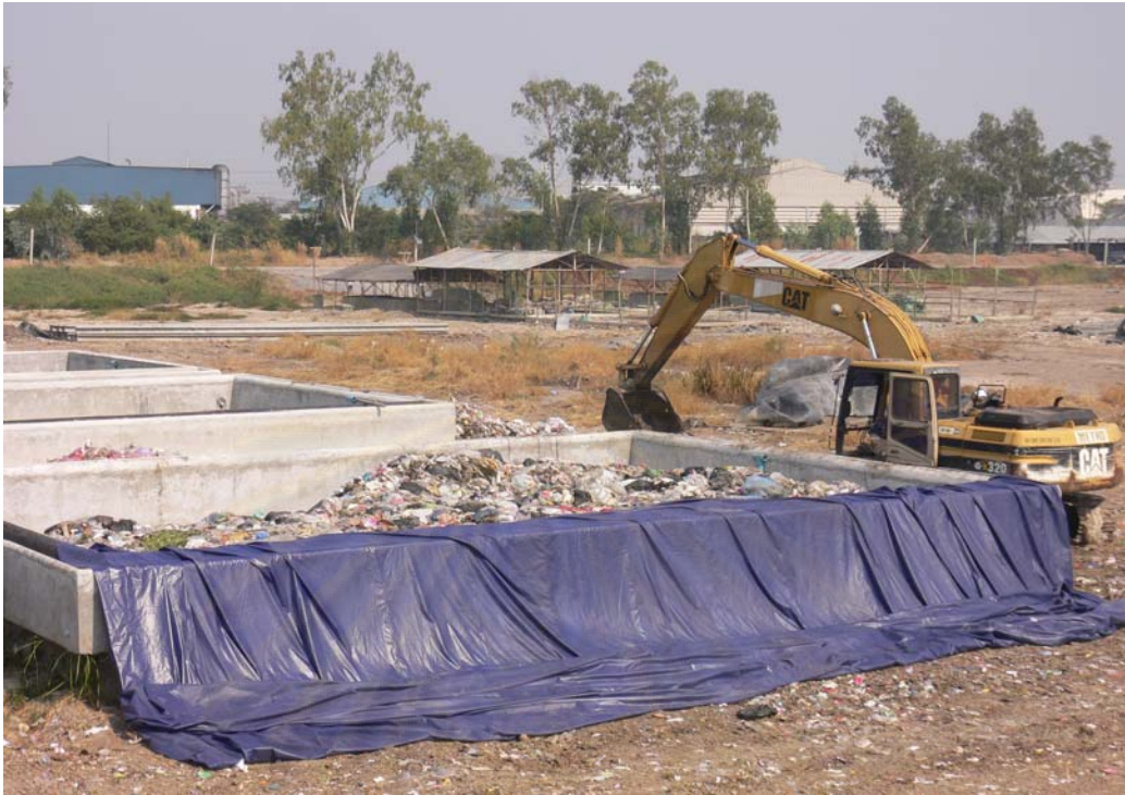
รูปที่ 4.2 บ่อหมักขยะ ขนาด 12x8x3.50 เมตร
