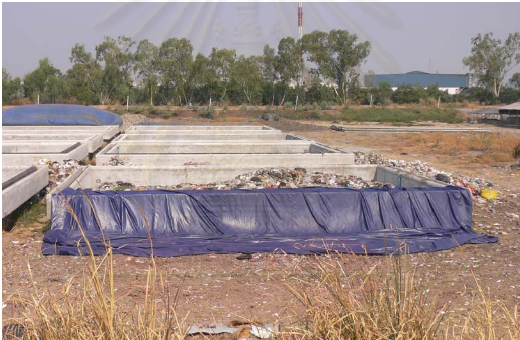
รูปที่ 4.1 บ่อหมักขยะ ขนาด 12x8x3.50 เมตร
