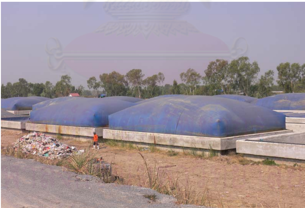
รูปที่ 4.3 บ่อหมักขยะ ขนาด 12x8x3.50 เมตร
