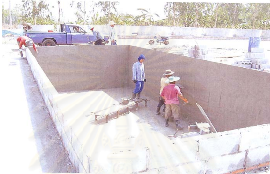
รูปที่ 3.4 การฉาบผนังภายในบ่อ
