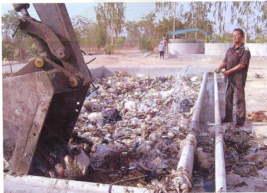
รูปที่ 3.12 เติมน้ำในบ่อหมัก ใช้สัดส่วนน้ำ 30% ของปริมาณขยะ
