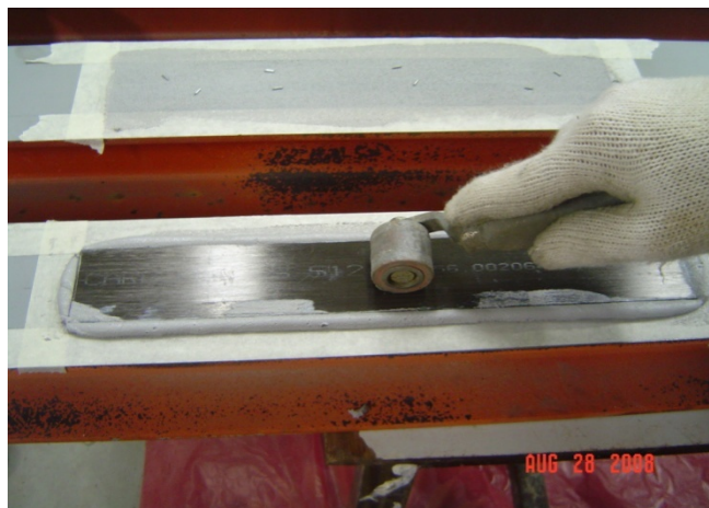
รูปที่ 4.5 การทำชั้นความหนาของวัสดุประสานให้มีความหนาเท่ากับ 1 มม.
