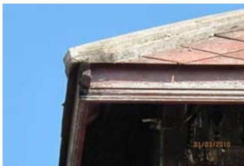
ภาพถ่ายเส้นที่ 4.38 การยึดเชิงกลอนด้วยเดือยหางเหยี่ยว
