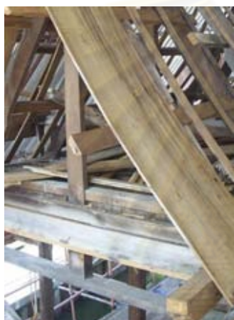
ภาพที่4.71 โครงสร้างบริเวณผนังหน้าจั่ว
