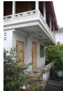
ฐานชั้นล่างอาคาร
