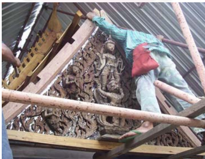
ภาพที่ 4.73 การติดตั้งหน้าบัน
