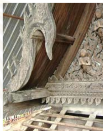
ภาพที่4.72 แผงหน้าจั่ว เข้าประกบกับแปหัวเสา
