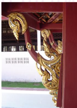
ภาพที่ 4.53 คันทวย (ซ้าย)คันทวยแบบเก่า (ขวา)คันทวยแบบใหม่
