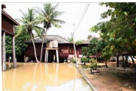
ภาพที่ 4.29 อาคารทางซ้ายในภาพ คือหอพระไตรปิฎก ตั้งอยู่ใกล้กับกุฏิสงฆ์
