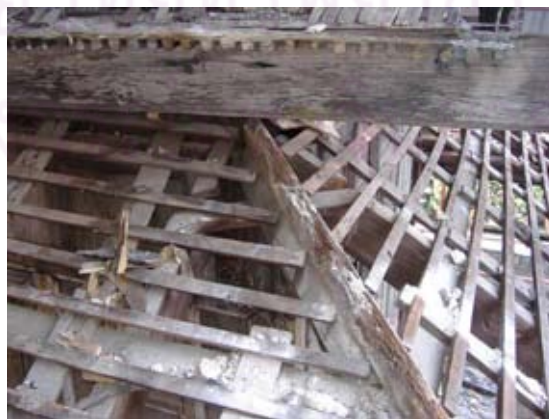
ภาพที่ 4.79 โครงสร้างหลังคากันสาด
