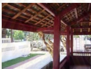
ภาพที่ 4.66 โครงสร้างหลังคากันสาด
