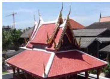
ภาพที่ 4.51 หลังคากันสาดรอบ
