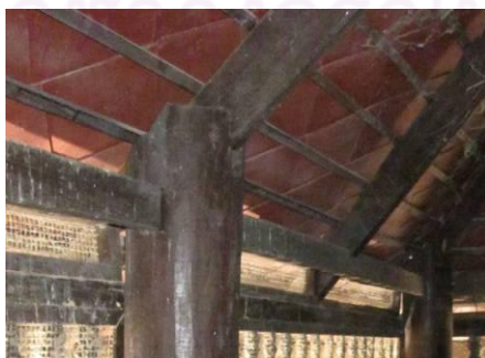
ภาพที่ 4.36 โครงสร้างหลังคาบ้าน
