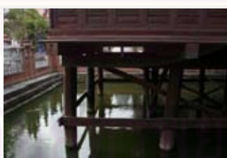
เสารับอาคาร
