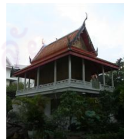
วัดสระเกศ กรุงเทพฯ วัดสังเวชวิศยาราม กรุงเทพฯ ภาพที่ 3.56 หอพระไตรปิฎกที่มีส่วนฐานเป็นผนังก่ออิฐถือปูน
