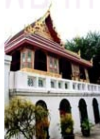
วัดสระเกศ กรุงเทพฯ วัดสังเวชวิศยาราม กรุงเทพฯ ภาพที่ 3.56 หอพระไตรปิฎกที่มีส่วนฐานเป็นผนังก่ออิฐถือปูน
