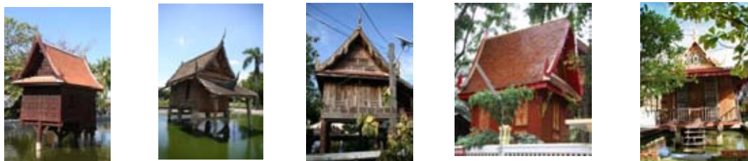
วัดยาง จ.เพชรบุรี วัดใหญ่สุวรรณาราม จ.เพชรบุรี วัดใหญ่สุวรรณาราม จ.เพชรบุรี วัดนรนาถสุนทริการาม จ.ททม. วัดป่าเกด จ.สมุทรปราการ ภาพที่ 2..35. หอพระไตรปิฎก ประเภทหลังคาทรงโรง ไม่มีระเบียง ส่วนหลังคาประกอบด้วยหลังคาเอกและไม่มีหลังคากันเสา
