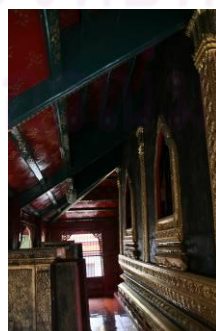
โครงสร้างหลังคากันสาด
