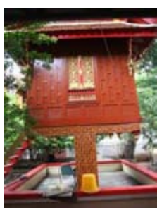
เสารับอาคารคสล.
