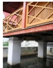
เสารับอาคาร
