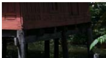
โครงสร้างเสาคาน
