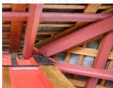
ภาพลายเส้นที่ 4.87 โครงสร้างหลังคาแกนสาด
