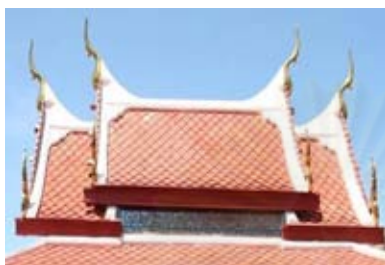
ภาพที่ 4.50 การซ้อนชั้นหลังคา
