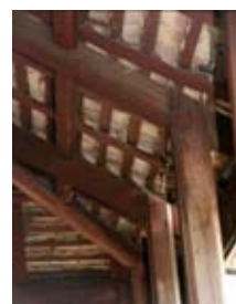
โครงสร้างหลังคาของอาคาร
