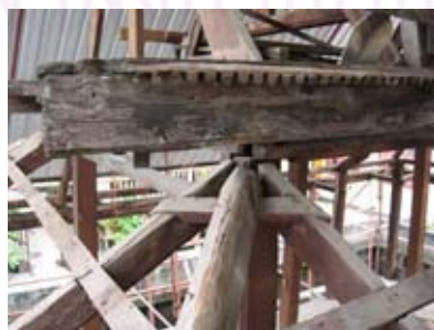
ภาพลายเส้นที่ 4.87 โครงสร้างหลังคาแกนสาด
