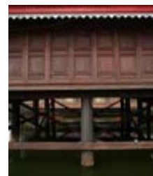
เสาอาคาร
