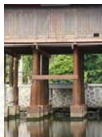
เสารับอาคาร
