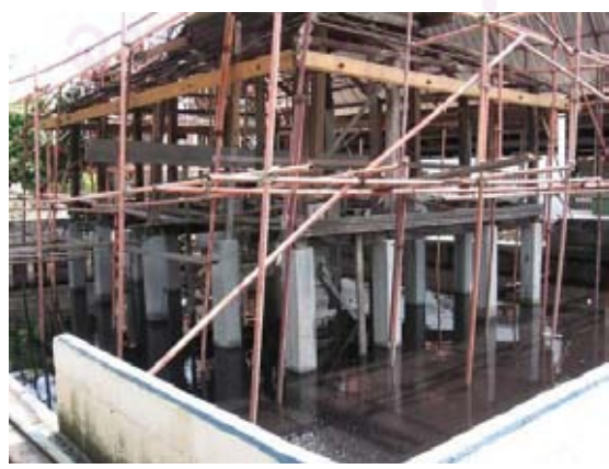
ภาพลายเส้นที่ 4.102 การต่อเสาอาคารระหว่างเสาไม้และเสาคอนกรีตเสริมเหล็ก
