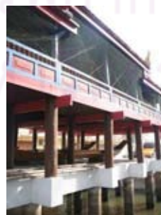
เสารองรับอาคาร
