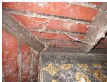
ภาพที่ 4.37 โครงสร้างบริเวณมุมหลังคาบ้าน
