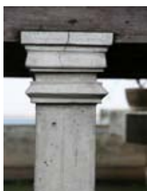
เสาปูนรับอาคาร
