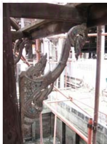
ภาพที่ 4.85 คันทวยขณะกำลังถอดออก
