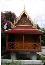
วัดดุสิตาราม กรุงเทพฯ วัดทองธรรมชาติ กรุงเทพฯ ภาพที่ 3.55 หอพระไตรปิฎกที่มีส่วนฐานเป็นเสาไม้คงเดิม
