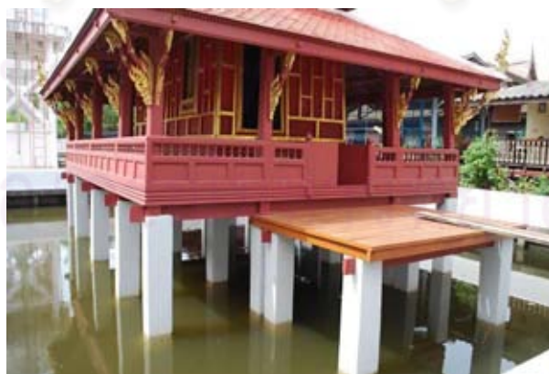
ภาพที่ 4.62 ฐานอาคาร ยกได้สูง
