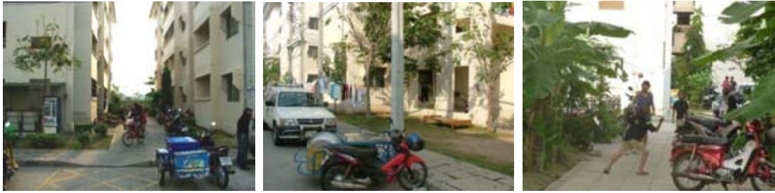
ภาพที่ 5.16 แสดงการใช้ที่ว่างระหว่างอาคารจอดรถจักรยานยนต์ ในโครงการบ้านเอื้ออาทรสมุทรปราการ 1
