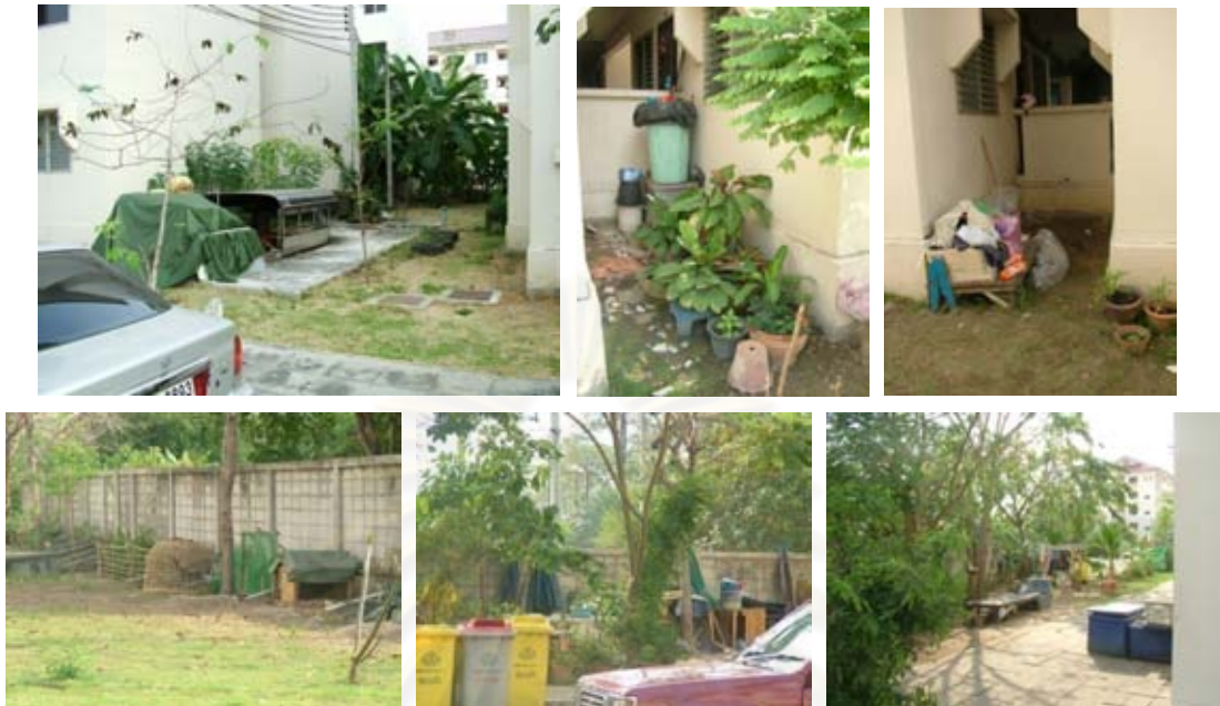
ภาพที่ 5.14 แสดงการใช้ที่ว่างระหว่างอาคารเก็บของในโครงการบ้านเอื้ออาทรสมุทรปราการ 1
