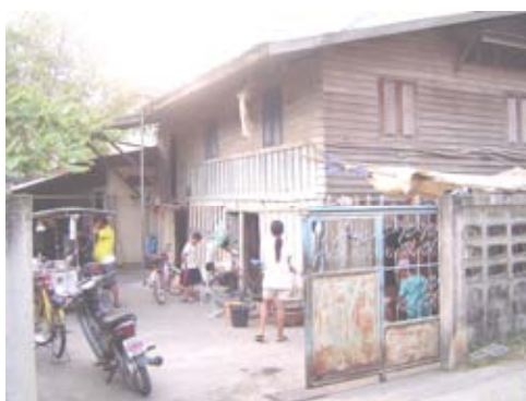
กลุ่มอาคารที่ 33 และ 34 จำนวนที่พักอาศัย 8 หน่วย
