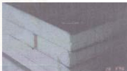
ภาพที่ 2.15 แสดงการซ่อมแซมฉนวนใยแก้วที่มีการฉีกขาดต้องใช้เทปใสหรือฟอยล์ปิดให้สนิท ที่มา : ฉนวนโฟม [ออนไลน์], 10 ธันวาคม 2553. แหล่งที่มา www.dede.go.th
