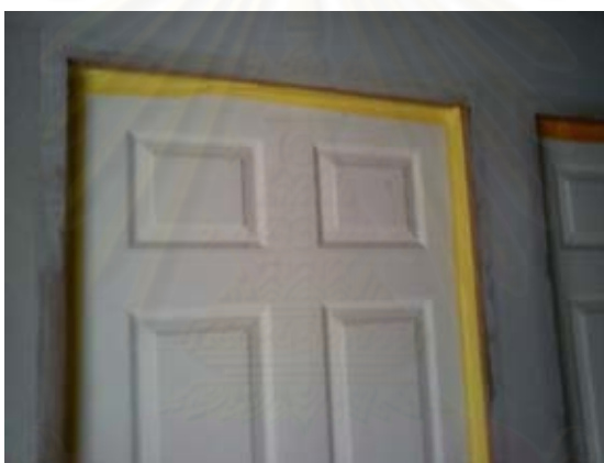
ภาพที่ 3.27 ภาพการป้องกันความร้อนเข้าสู่ห้องทดลองจากทางช่องว่างของประตู
