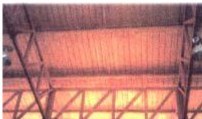
ภาพที่ 2.17 แสดงการฉีดพ่นฉนวนโฟมใต้ฝ้าเพดาน ที่มา : ฉนวนโฟม [ออนไลน์] , 10 ธันวาคม 2553. แหล่งที่มา www.dede.go.th
