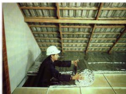
ภาพที่ 2.12 แสดงการติดตั้งฉนวนใยแก้วบริเวณเหนือฝ้าเพดาน
