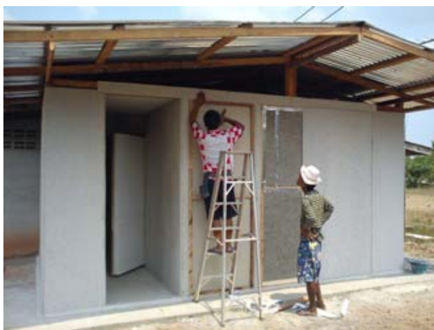
ภาพที่ 3.20 ภาพการติดตั้งฉนวนความร้อน
