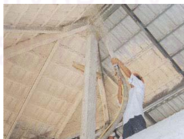
ภาพที่ 2.18 แสดงการใช้งานฉนวนบริเวณหลังคา และผนัง ที่มา : ฉนวนโฟม [ออนไลน์] , 10 ธันวาคม 2553. แหล่งที่มา www.dede.go.th
