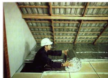
ภาพที่ 5.8 ฉนวนเส้นใยบรรจุในถุง FOIL และการติดตั้ง
