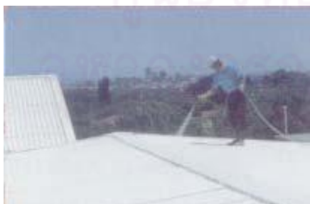
ภาพที่ 2.18 แสดงการใช้งานฉนวนบริเวณหลังคา และผนัง ที่มา : ฉนวนโฟม [ออนไลน์] , 10 ธันวาคม 2553. แหล่งที่มา www.dede.go.th
