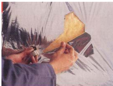
ภาพที่ 2.14 แสดงการซ่อมแซมฉนวนใยแก้วที่มีการฉีกขาดต้องใช้เทปใสหรือฟอยล์ปิดให้สนิท ที่มา : ใยแก้ว [ออนไลน์], 10 ธันวาคม 2553. แหล่งที่มา www.dede.go.th
