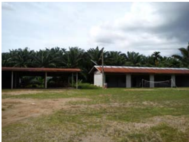
ภาพที่ 3.11 ภาพสถานที่ก่อสร้างห้องทดลอง
