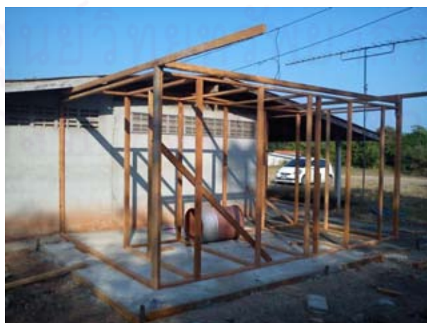
ภาพที่ 3.16 ภาพการวางโครงสร้างห้องทดลอง
