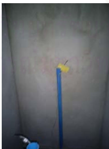
ภาพที่ 3.25 ภาพการติดตั้งอุปกรณ์
