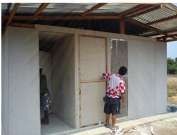
ภาพที่ 3.21 ภาพการติดตั้งฉนวนความร้อน
