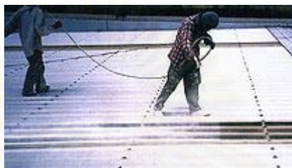
ภาพที่ 2.10 แสดงบริเวณผิวหลังคาขณะที่กำลังทาและพ่นเซรามิกโค้ตติ้ง ที่มา : เซรามิกโค้ตติ้ง [ออนไลน์], 10 ธันวาคม 2553. แหล่งที่มา www.dede.go.th
