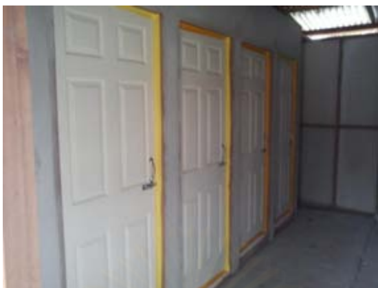
ภาพที่ 3.26 ภาพการป้องกันความร้อนเข้าสู่ห้องทดลองจากทางช่องว่างของประตู
