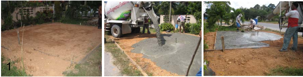
ขั้นตอนที่ 1 การปรับพื้นที่และการทำงานฐานห้องทดลอง
