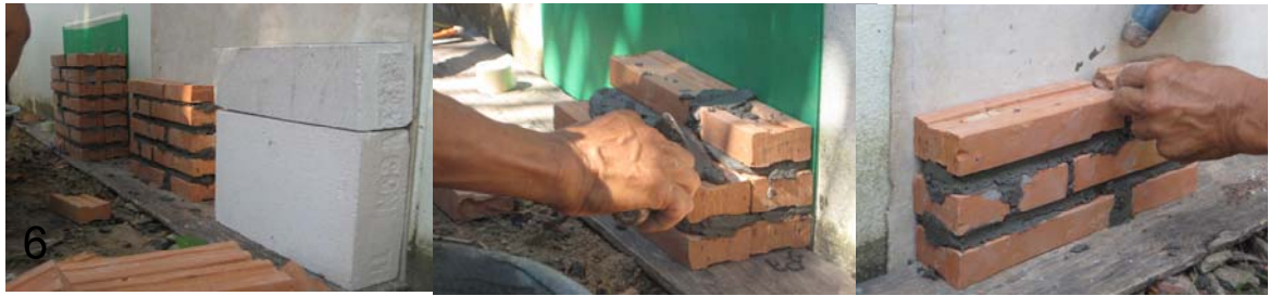
ขั้นตอนที่6 การก่อสร้างมวลสารผนังภายนอกทั้ง 3 ชนิด
