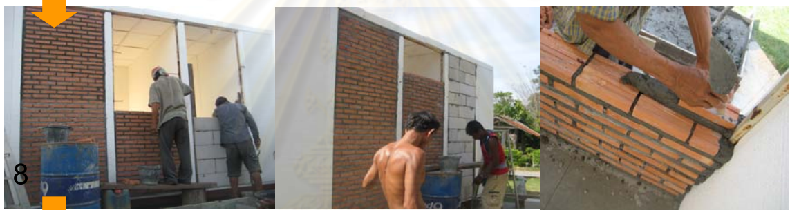
ขั้นตอนที่8 การก่อสร้างมวลสารผนังภายนอกทั้ง 3 ชนิด
