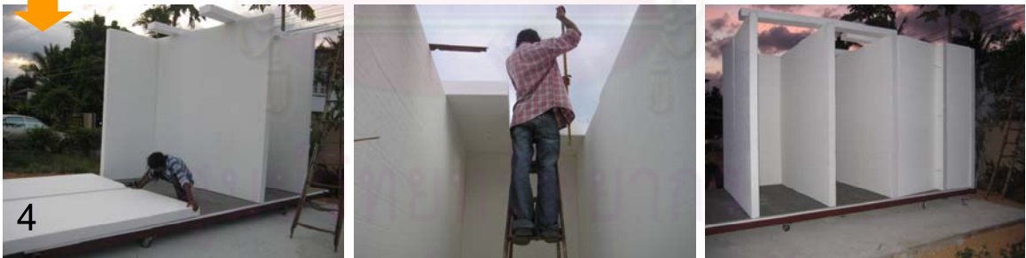
ขั้นตอนที่ 4 การประกอบผนังโฟมหนา โฟมหนา 4 นิ้ว
