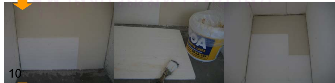
ขั้นตอนที่10 การปิดวัสดุฉนวนโฟมเพื่อกำหนดค่าสัมประสิทธิ์การถ่ายเทความร้อนของวัสดุ ภาพที่ 3.8 ขั้นตอนการทำห้องทดลอง
