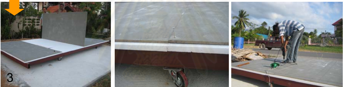
ขั้นตอนที่ 3 การวางแผ่นโฟมเพื่อกันความชื้น และวางแผ่นพื้นวีว้าบอร์ด 15 มม.
