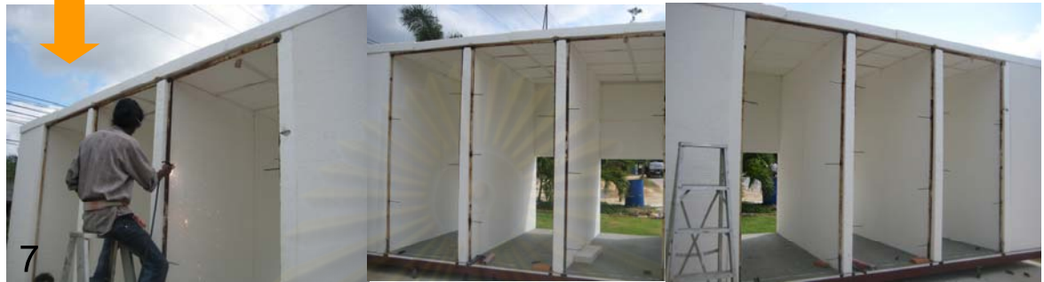
ขั้นตอนที่7 การก่อสร้างห้องทดลอง
