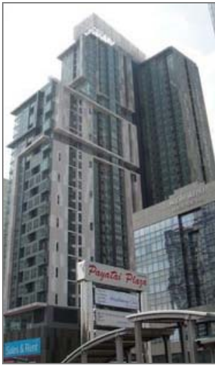
ภาพที่ 15 รูปแบบอาคาร
