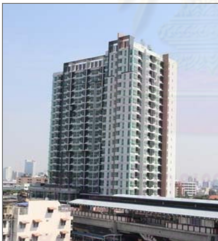
ภาพที่ 10 รูปแบบอาคาร
