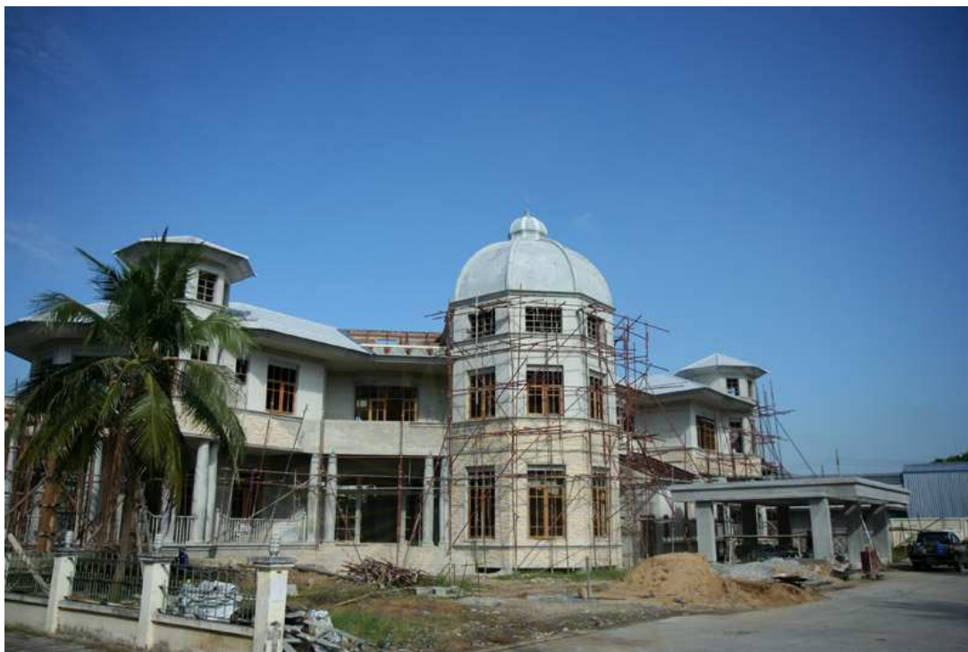
ภาพที่ 5.76 แสดงหลังคาโดมที่เสร็จสมบูรณ์
