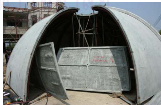
ภาพที่ 5.45 แสดงการเว้นชิ้นงานด้านสุดท้าย
