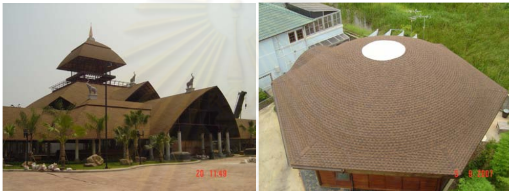
ภาพที่ 2.77 ตัวอย่างงานที่ใช้ Asphalt Shingles
