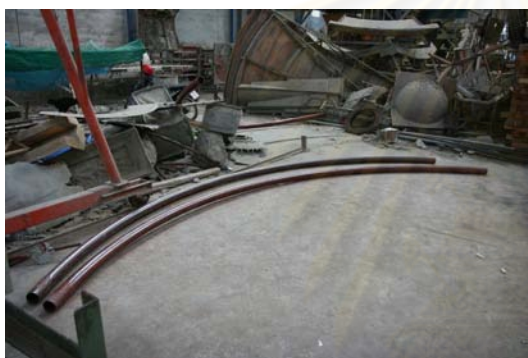
ภาพที่ 5.17 แสดงการตัดเหล็กให้ได้ตามขนาด
