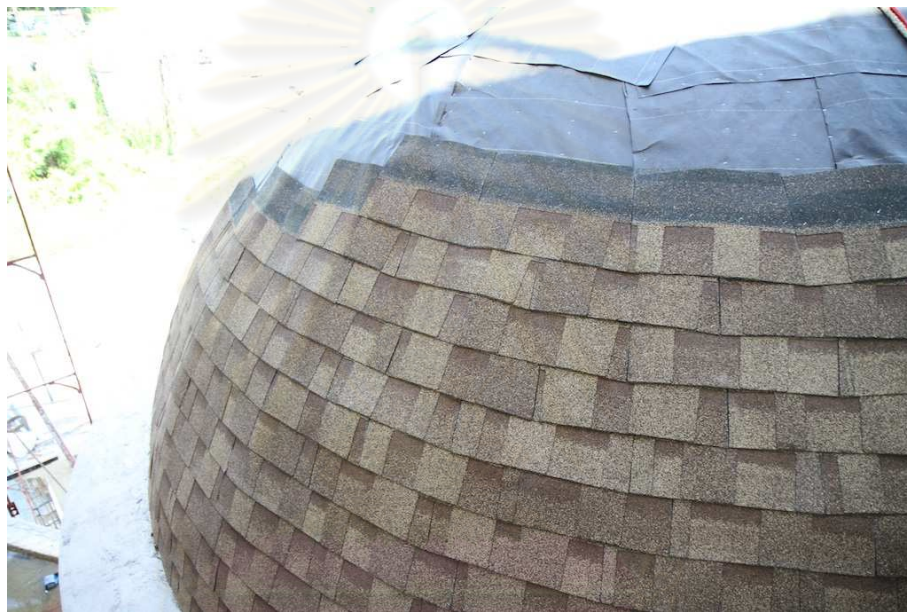
ภาพที่ 5.113 แสดงพื้นผิวเมื่อปูแผ่นยางมะตอยแล้ว
