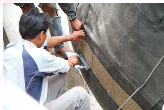
ภาพที่ 5.104 แสดงวิธีการติดแผ่นยางมะตอย
