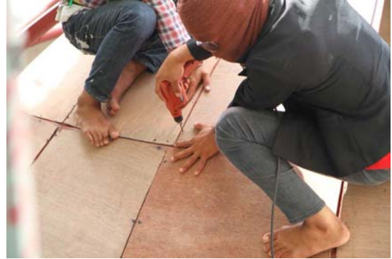
ภาพที่ 5.94 แสดงวิธีการยึดแผ่นไม้กับโครงสร้าง
