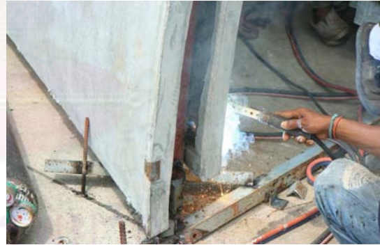
ภาพที่ 5.49 แสดงการเชื่อมยึดชิ้นงานกับโครงเหล็ก
