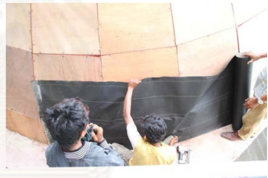
ภาพที่ 5.96 แสดงปัญหาในการปูแผ่นให้ได้รูปทรงโดม
