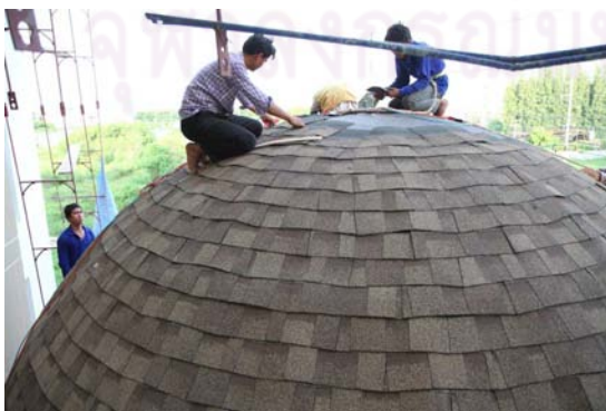
ภาพที่ 5.114 แสดงการติดแผ่นยางมะตอยชั้นสุดท้าย
