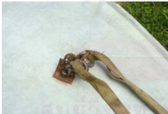
ภาพที่ 5.31 แสดงการฝังจุดยึดสำหรับยกชิ้นงาน
