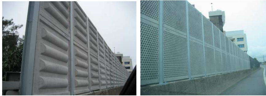
ภาพที่ 2.53 แสดงการใช้ GRC. ในงานผนังกันเสียงทางด่วน
