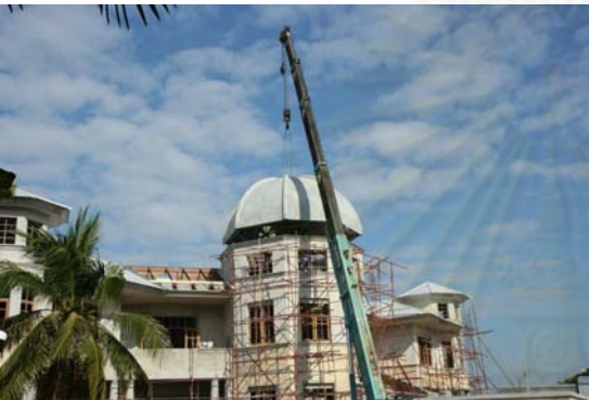
ภาพที่ 5.64 แสดงการตรวจสอบระดับและ ตำแหน่งชิ้นงานกับโครงสร้างอาคาร
