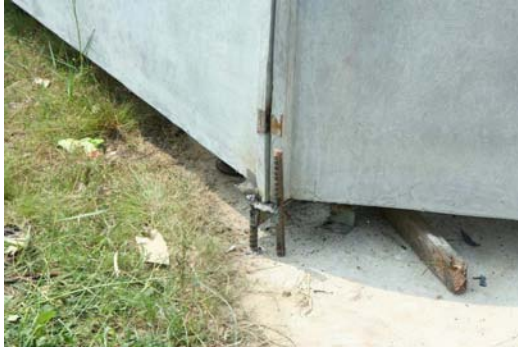
ภาพที่ 5.38 แสดงจุดยึดในการติดตั้งชิ้นงาน
