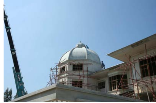
ภาพที่ 5.69 แสดงการเชื่อมยึดยอดโดมเข้าด้วยกัน
