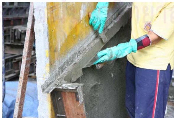
ภาพที่ 5.16 แสดงการขึ้นขอบชั้นงาน
