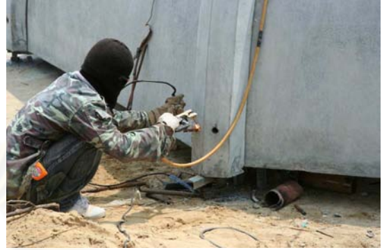
ภาพที่ 5.47 แสดงการเชื่อมยึดสันโดมกับชิ้นงาน
