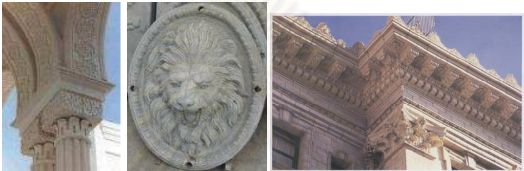
ภาพที่ 2.50 แสดงการใช้ GRC. ในงานประดับอาคาร
