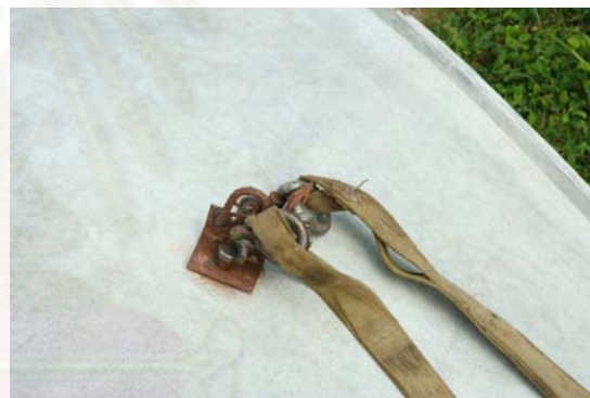
ภาพที่ 5.59 แสดงจุดที่ฝังเตรียมไว้ในการยกติดตั้ง
