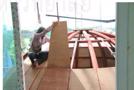
ภาพที่ 5.92 แสดงการตัดแผ่นไม้ให้พอดีกับช่อง
