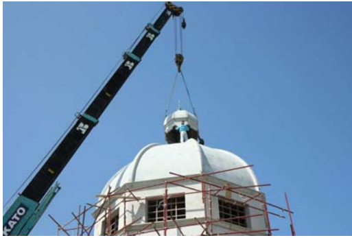
ภาพที่ 5.68 แสดงการตรวจสอบตำแหน่งที่ติดตั้ง
