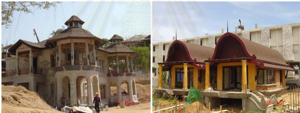
ภาพที่ 2.74 ตัวอย่างงานที่ใช้ Asphalt Shingles
