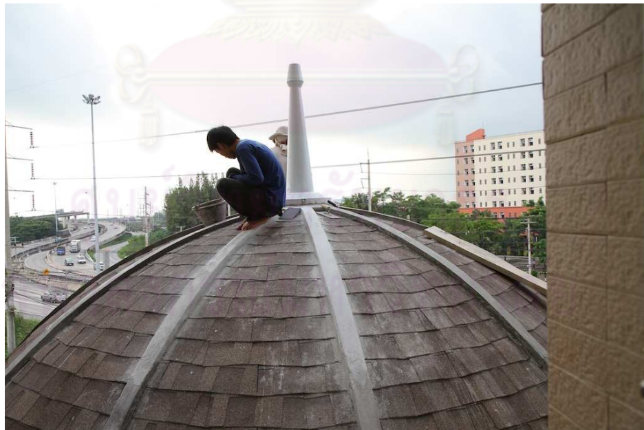
ภาพที่ 5.117 แสดงการติดตั้งยอดแหลมของโดม
