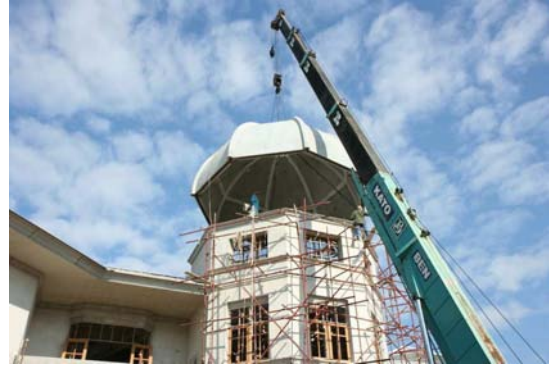
ภาพที่ 5.63 แสดงการยกชิ้นงานสู่โครงสร้างอาคาร
