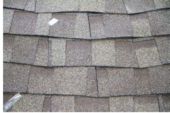
ภาพที่ 5.112 แสดงการปูแผ่นยางซ้อนทับกัน
