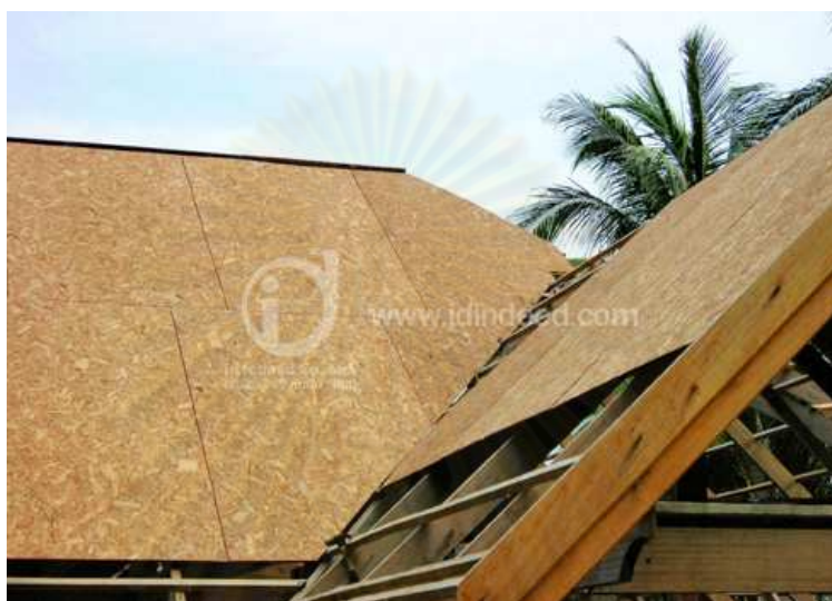
ภาพที่ 2.67 แสดงวิธีการยึดไม้อัด
