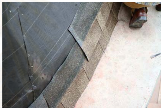
ภาพที่ 5.108 แสดงการติดแผ่นยางมะตอย ทับแผ่น Starter
