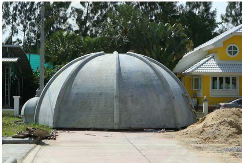
ภาพที่ 5.54 แสดงการติดตั้งหลังคาโดมจนครบทุกด้าน
