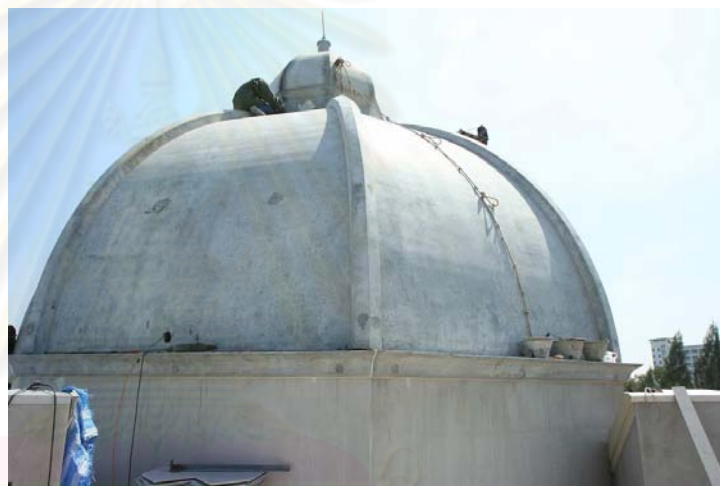
ภาพที่ 5.71 แสดงการเชื่อมยึดยอดโดมเข้าด้วยกัน
