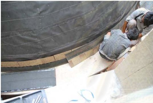
ภาพที่ 5.107 แสดงการติดแผ่นยางมะตอย ทับแผ่น Starter
