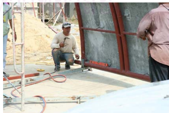
ภาพที่ 5.34 แสดงการติดตั้งชิ้นงานบนจุดอ้างอิง
