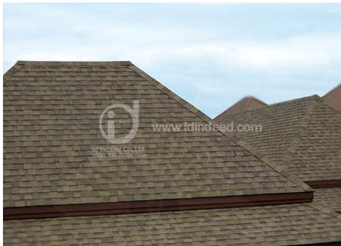
ภาพที่ 2.73 แสดงหลังคาที่ปูแผ่น Asphalt Shingles เรียบร้อยแล้ว
