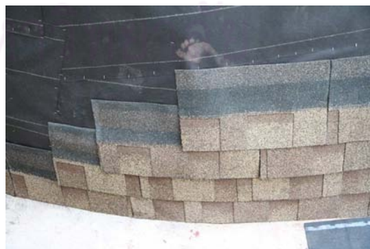
ภาพที่.110 แสดงการติดแผ่นยางมะตอยชั้นที่ 3และ4
