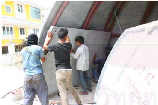
ภาพที่ 5.48 แสดงการเริ่มติดตั้งชิ้นงานด้านใน
