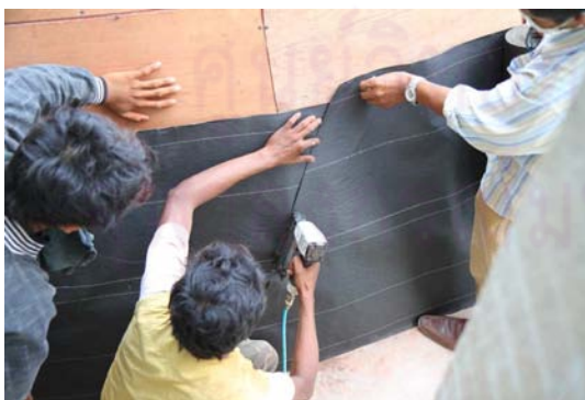
ภาพที่ 5.97 แสดงการยึดแผ่นยางกับแผ่นไม้อัด
