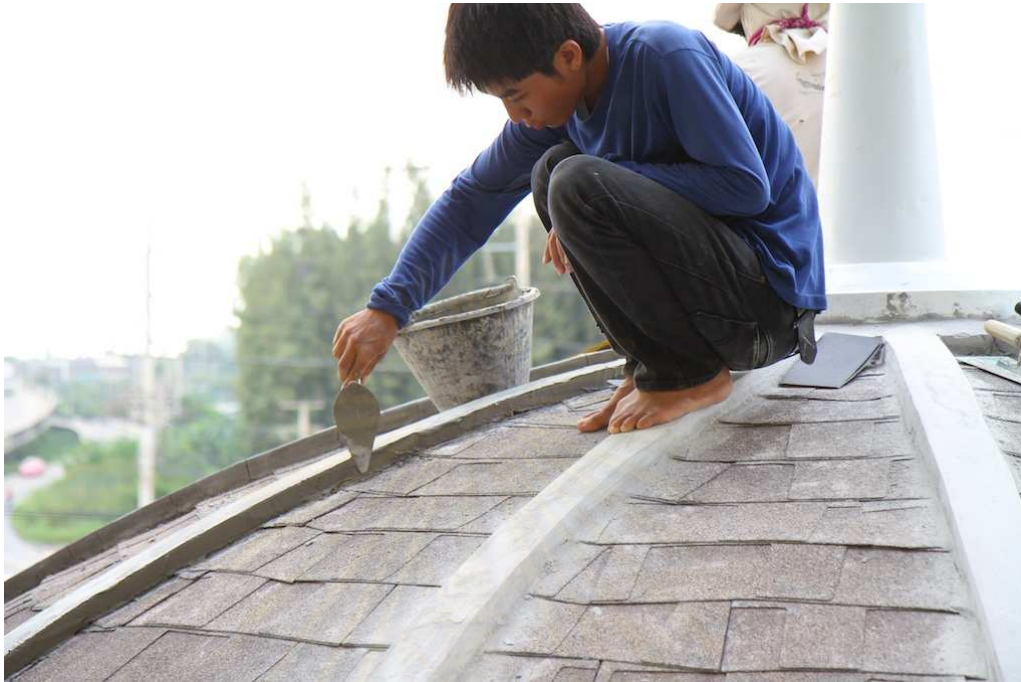
ภาพที่ 5.118 แสดงการขึ้นปูนทำแนวสันหลังคา
