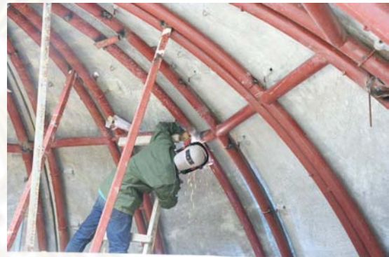
ภาพที่ 5.41 แสดงวิธีการยึดเชื่อมชิ้นงาน
