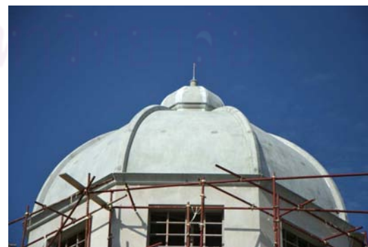
ภาพที่ 5.73 แสดงการเก็บรอยต่อ Sealant ด้วย Polyuretain
