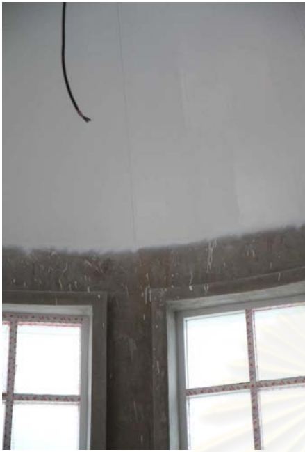
ภาพที่ 5.121 แสดงการติดไม้อัดด้านใน
