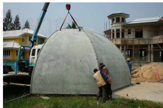
ภาพที่ 5.37 แสดงการติดตั้งชั้นงานที่ 2
