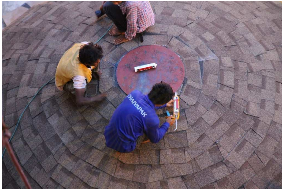
ภาพที่ 5.116 แสดงการเก็บรอยต่อทั้งหมดโดยใช้ Sealant
