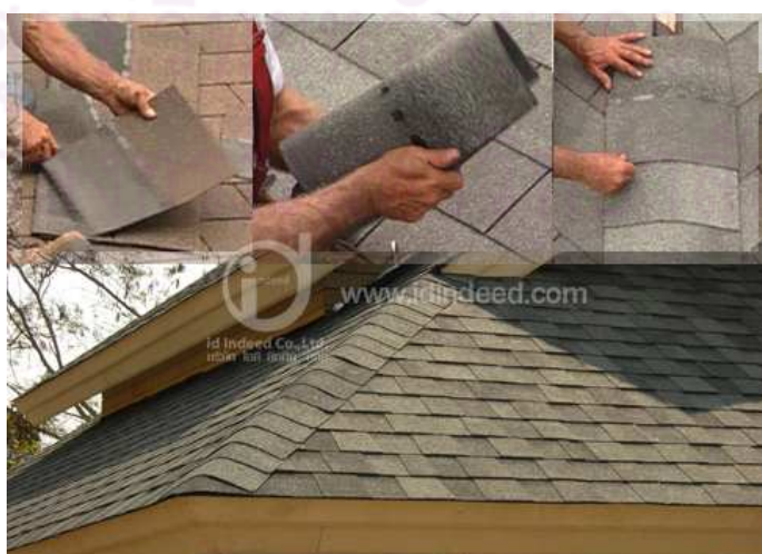
ภาพที่ 2.72 แสดงวิธีการทำกรอบสัน
