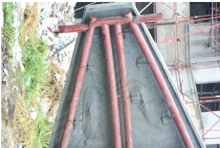
ภาพที่ 5.20 แสดงการยึดโครงเหล็กกับชิ้นงาน และการเผื่อความยาวด้านหัวและท้าย
