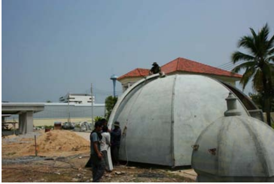
ภาพที่ 5.46 แสดงการติดตั้งสันโดม
