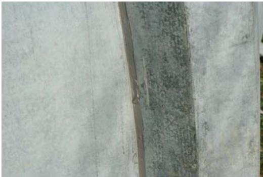
ภาพที่ 5.56 แสดงการ Sealant ด้วย Polyuretain
