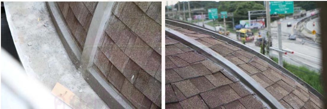
ภาพที่ 5.119 แสดงการขึ้นขอบปูนด้านล่าง
