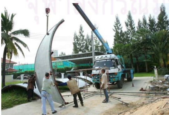
ภาพที่ 5.33 แสดงการเริ่มติดตั้งชิ้นงานบนจุดอ้างอิง
