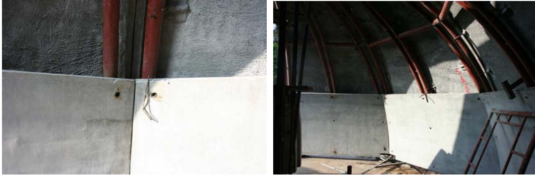
ภาพที่ 5.52 แสดงรอยต่อของชิ้นงาน
