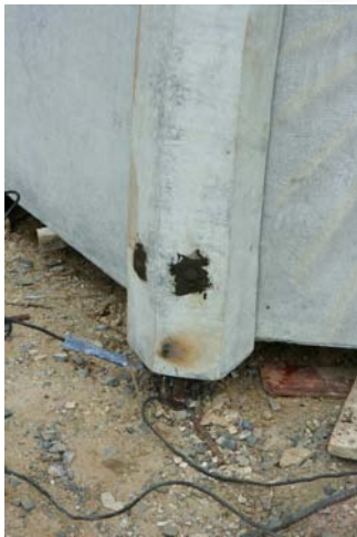
ภาพที่ 5.70 แสดงการ Grout
