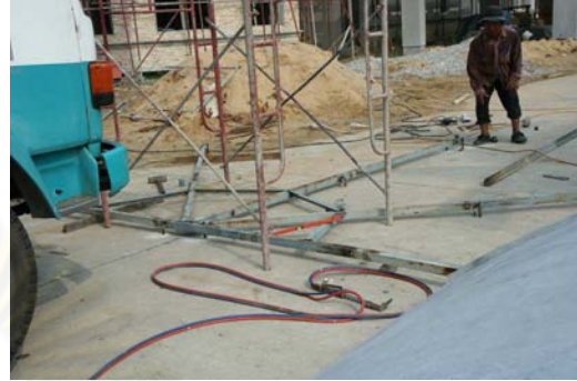
ภาพที่ 5.30 แสดงการประกอบเหล็กฉากตามผัง
