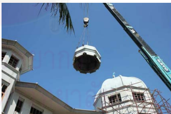
ภาพที่ 5.67 แสดงการยกส่วนยอดโดมขึ้นติดตั้ง
