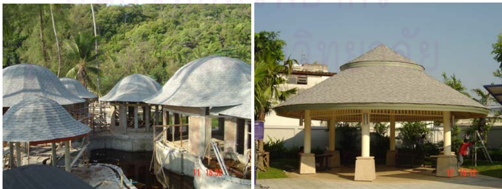
ภาพที่ 2.75 ตัวอย่างงานที่ใช้ Asphalt Shingles
