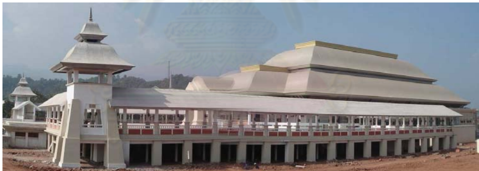
ภาพที่ 2.55 แสดงการใช้ GRC. ในงานหลังคา
