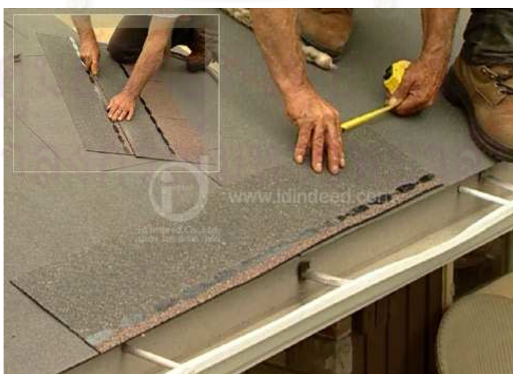
ภาพที่ 2.70 แสดงวิธีการปูแผ่น starter
