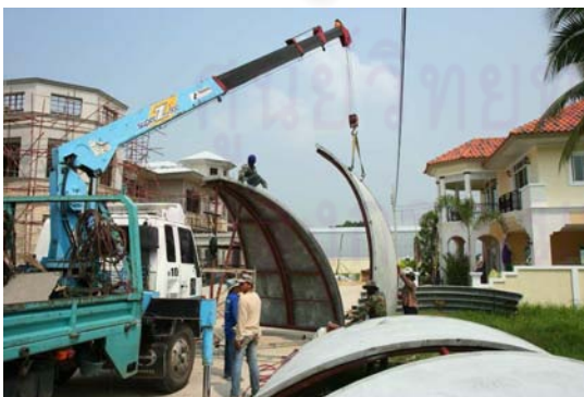
ภาพที่ 5.36 แสดงการติดตั้งชั้นงานที่ 2
