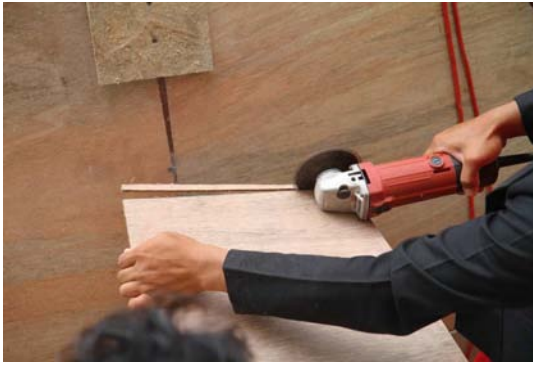
ภาพที่ 5.93 แสดงการตัดแผ่นไม้ให้ได้ขนาด
