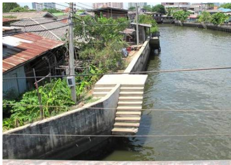
แนวเขื่อนป้องกันน้ำท่วมสูงและบันไดลอย
