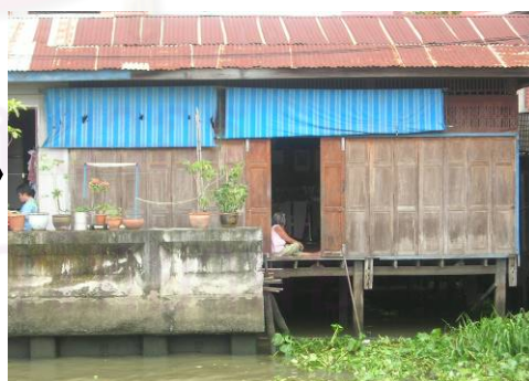
หลังมีแนวเขื่อนป้องกันน้ำท่วม
