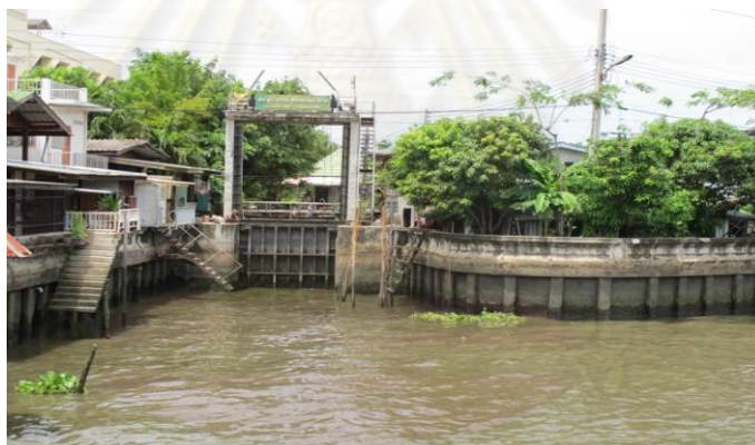
ภาพที่ 4.11 แนวเขื่อนป้องกันน้ำท่วมและประตูระบายน้ำริมคลอง (ที่มา: โดยผู้วิจัย, 2553)
