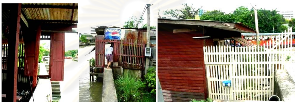
ภาพที่ 6.9 ประตูเปิดปิดกั้นบนสันเขื่อนและรั้วกันทางเดินบนสันเขื่อน
