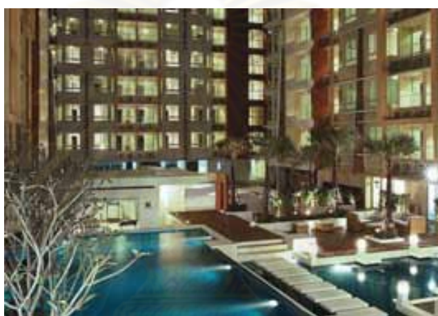
รูปภาพที่ 4 74 ภาพแสดงมุมมองสระว่ายน้ำ อาคารชุด IVY (ลาดพร้าว 20)
