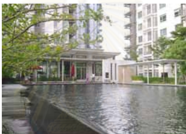
รูปภาพที่ 4 105 ภาพแสดงส่วนน้ำล้นของสระว่ายน้ำ อาคารชุด THE ROOM (ลาดพร้าว 32)
