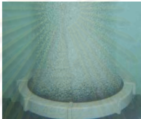
รูปที่ 2.11 ภาพแสดงอุปกรณ์กระจายอากาศชนิดแผ่นจาน
