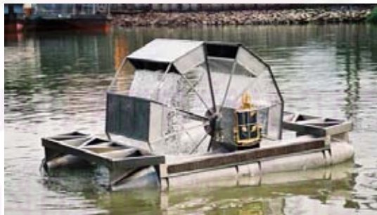
รูปที่ 2.20 ภาพแสดงอุปกรณ์เติมอากาศทางกลบนผิวน้ำในแนวนอน (กังหันชัยพัฒนา)
