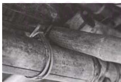
รูปที่ 2.23: แสดงลักษณะการผูกมัดด้วยหวาย
