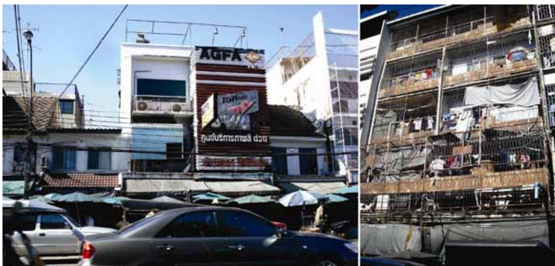
ภาพที่ 5-07 สภาพการต่อเติมอาคารตึกแถว ย่านปากคลองตลาด (ที่มา: โดยผู้วิจัย, 2551)
