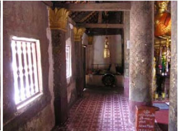
ภาพที่ 5-113 การใช้ช่องแสงลูกกรงมะหวด ภายในสิมวัดศรีบุญเรือง ช่วยควบคุมความเข้มข้น ของแสง ที่มีผลกระทบต่อการรับรู้ตัวลายรดน้ำที่ ประดับอยู่ตามผนังและเสา
