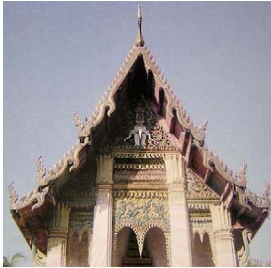
ภาพที่ 4-177 สิมวัดทุ่งศรีเมืองก่อนบูรณะ
