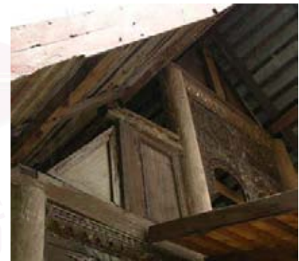
สีหน้าสิมวัดหมากมี เป็นสิมในเขตชนบท เป็นสีหน้าแบบโครงสร้างจั่ว สังเกตุการ ติดตั้งชั้นบัวหงายใต้จั่ว อันถือเป็น เอกลักษณ์เด่นของสีหน้าประเภทนี้
