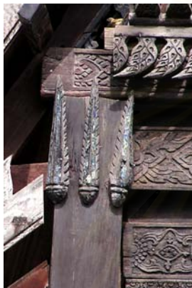
ภาพที่ 4-254 บัวหัวเสา ทำกลีบบัวไม้แปะแบบช่างท้องถิ่น
