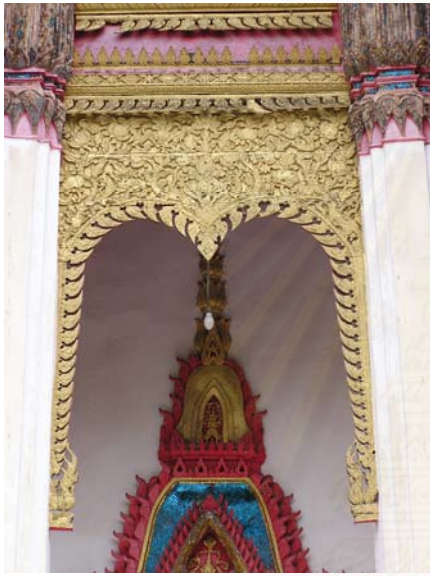
ภาพที่ 4-137 ซึ้งผึ้งเสาร่วมในด้านหน้าสิม เป็นลายพุดตาน ประดับสำหรับรายรวงผึ้งแบบกระจิงรวน อิทธิพลศิลปะภาคกลาง แต่เป็นฝีมือช่างท้องถิ่น
