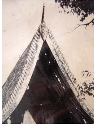
ภาพที่ 4-2 และ 4-3 โหง(ช่อฟ้า) และรอยระกาไม้แกะสลัก ตัวรอยระกาเป็นแบบไม่มีนาคสะดุ้ง (ตามอย่างสถาปัตยกรรมล้านช้าง) แต่มีใบระกาแบบสถาปัตยกรรมภาคกลาง ตกแต่งด้วยการฝังกระจกจีนขาว เข้าไปในเนื้อไม้ เป็นลาย “ลูกฟักกะปู้”
