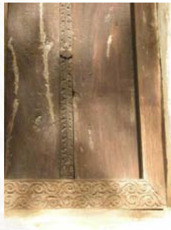
ภาพที่ 4-286 และ 4-287 หน้าต่างกรอบเรียบไม่มีการทำซุ้ม แต่มีการแกะลายที่กรอบเซ็ดหน้าและตัวอกเลาเป็นลายก้านขดเครือเถา หัวม้วน แบบอิทธิพลศิลปะลาว
