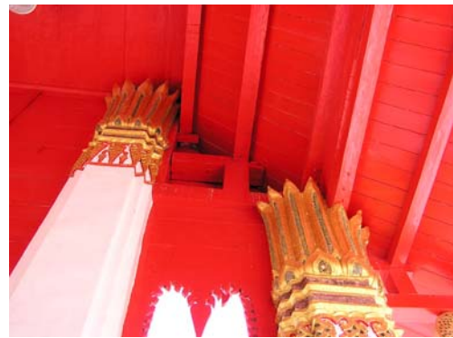
(บน) ภาพที่ 4-181 โครงสร้างไม้ตั้งใหม่
