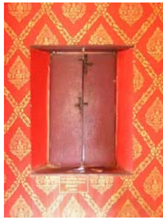
ภาพที่ 4-80 และ 4-81 ประตูหน้าต่างภายในบานไม้แผ่นเรียบ ทาสี ไม่มีลวดลาย กรอบบานแฝดละ
