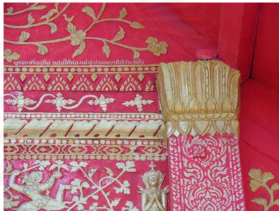
ภาพที่ 4-57 ชื่อไม้หน้ากระดาน บัวหงายประดับลายกลีบบัวดอกออก แบบชุดลายรับสีหน้าของสถาปัตยกรรมล้านช้าง ที่ส่งอิทธิพลมายังลิมหลังนี้
