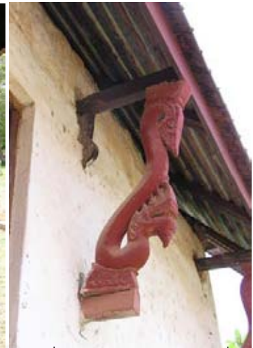
ภาพที่ 4-103 คันทวยหูช้างแบบเก่า ภาพที่ 4-104 คันทวยนาค รับ ภาพที่ 4-105 ส่วนคันทวยเก่าที่ถูก อิทธิพลจากภาคกลาง ฝีมือช่างท้องถิ่น ก่อผนังทับ
