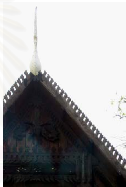
รอยระกาไม้แกะ สิมวัดแจ้ง ซึ่งรับแบบจาก ภาคกลาง แต่ใบระกาดัดรูปใบวันแฉ่น ของสถาปัตยกรรมล้านช้าง สร้างสรรค์โดยช่างท้องถิ่น
