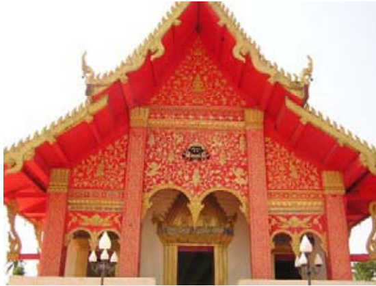
ภาพที่ 5-33 การวางระยະแปะของห้อง(เมื่อเทียบกับสัดส่วนอาคาร) ของสิมวัดพระเหลาเทพนิมิต จ.อำนาจเจริญ ซึ่งเป็นสถาปัตยกรรมทางภาคอีสาน ที่ได้รับอิทธิพลทางโครงสร้างหลังคา ซึ่งมีความสัมพันธ์กับรูปทรงอาคาร มาจากสถาปัตยกรรมล้านช้าง
