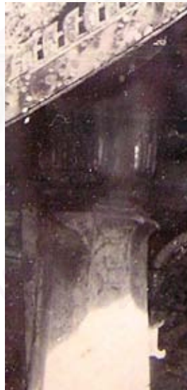
ภาพที่ 4-6 และ 4-7 บัวหัวเสาร่วมในและเสาร่วมนอกตามลำดับ เป็นบัววงกลหัวเสาทรงสูง 2 ชั้น และทรงเตี้ยชั้นเดียวแบบศิลปะล้านช้าง
