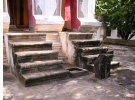
ภาพที่ 4-36 บันไดทางขึ้นอาคารรูปแบบเรียบง่ายตามวิถีชีวิตของคนอีสาน
