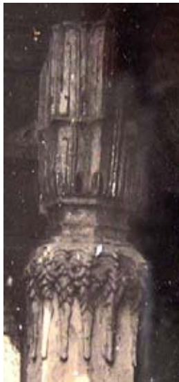
ภาพที่ 4-6 และ 4-7 บัวหัวเสาร่วมในและเสาร่วมนอกตามลำดับ เป็นบัววงกลหัวเสาทรงสูง 2 ชั้น และทรงเตี้ยชั้นเดียวแบบศิลปะล้านช้าง
