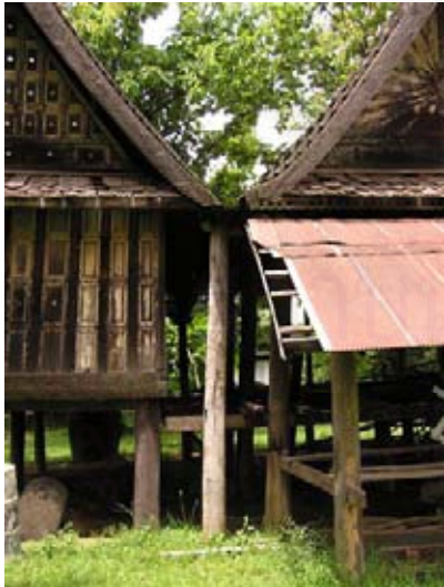
ภาพที่ 6-45 โครงสร้างกุฏิลักษณะเป็นเฮือนโขง แยกเป็นเอกเทศจากกัน ส่วนนี้ใช้การตั้งเสาขึ้นไปรับรางน้ำ
