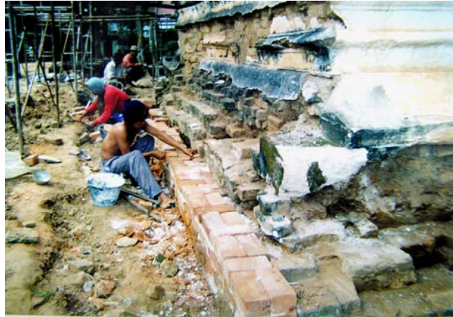
ภาพที่ 5-35 ภาพแสดงการบูรณะกะออิฐขนาดใหญ่เหมือนอิฐโบราณ
