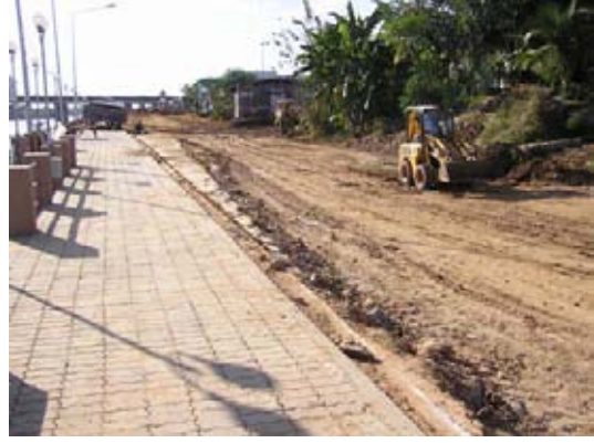
ภาพที่ 6-14 โครงการทำถนนสาธารณะริมน้ำผ่านเขตวัดด้านที่ติดกับแม่น้ำมูลทางทิศใต้
