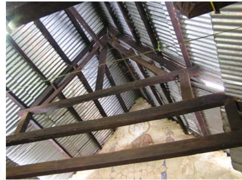
ภาพที่ 4-274 ตั้งโครงไม้ตั้งใหม่รับโครงจั่วจันทัน
