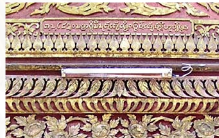
ภาพที่ 5-62 หน้ากระดานตั้งกระจัง แบบ สถาปัตยกรรมไทย รองรับสีหน้าแบบโครง จั่วจันทัน สีหน้าสิมวัดล่องคูณ
