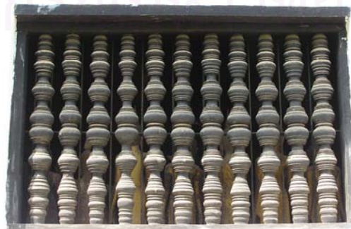
ภาพที่ 5-85 หน้าต่างลูกกรงไม้กลึง แบบลูกกรงมะหวด อาสามวัดวิฑูณ เมืองหลวงพระบาง
