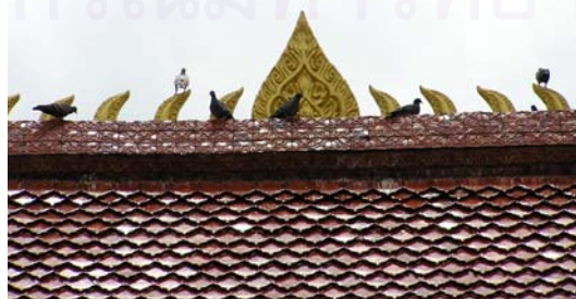
ภาพที่ 4-54 ช่อฟ้า(สัตบริภัณฑ์)กระเบื้องเคลือบรูปใบโพธิ์ และปักใบระกาคล้ายใบวันแล่นที่สันหลังคาตามอิทธิพลสถาปัตยกรรมล้านช้าง มุงกระเบื้องดินเผาสุโขทัยใบโพธิ์
