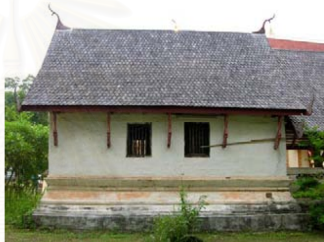
ภาพที่ 5-19 ลักษณะการเจาะช่องหน้าต่างเรียบ ไม่มีชุ่มประดับ ที่สิมเก่าวัดหมากมี จ.อุบลราชธานี ช่องหน้าต่างตั้งลูกกรง มะหวด เป็นลักษณะที่สืบทอดมาจากสถาปัตยกรรมล้านช้าง
