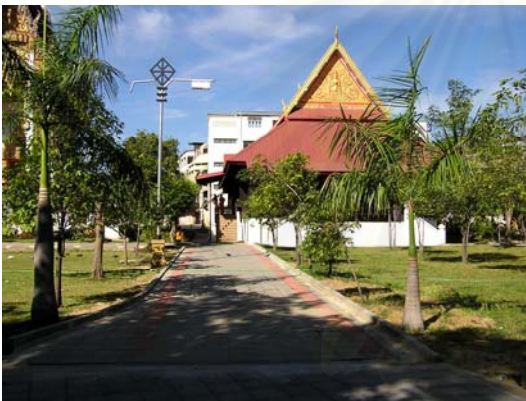
ภาพที่ 6-3 คอนกรีตบล็อกบริเวณทางเข้าสู่หอแจก
