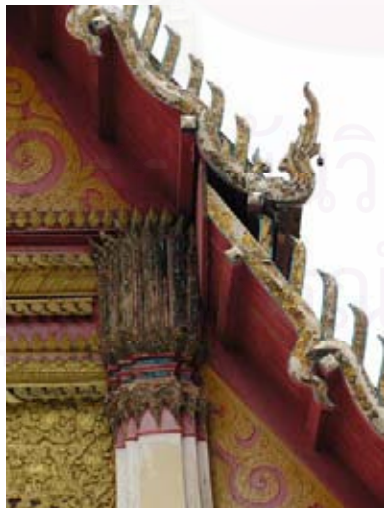
ภาพที่ 4-126 ตำแหน่งหางหงส์ของดัดหลังคา จั่วบนยื่นเลยแนวเสาออกมา แสดง โครงสร้างหลังคาแบบผสมผสาน
