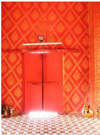
ภาพที่ 4-80 และ 4-81 ประตูหน้าต่างภายในบานไม้แผ่นเรียบ ทาสี ไม่มีลวดลาย กรอบบานแฝดละ
