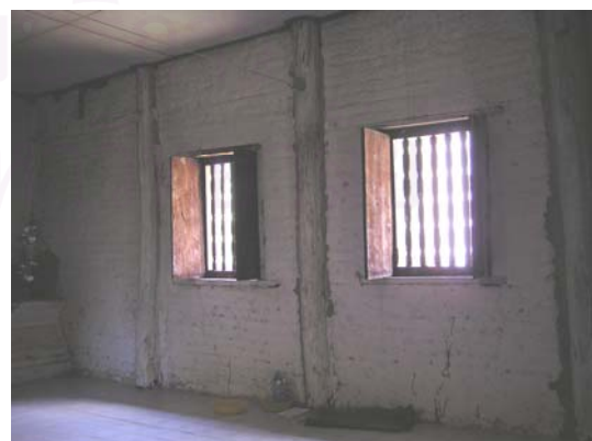
ภาพที่ 4-118 ผนังก่ออิฐฉาบปูนภายในลิม
