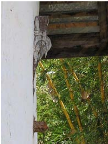
ภาพที่ 4-103 คันทวยหูช้างแบบเก่า ภาพที่ 4-104 คันทวยนาค รับ ภาพที่ 4-105 ส่วนคันทวยเก่าที่ถูก อิทธิพลจากภาคกลาง ฝีมือช่างท้องถิ่น ก่อผนังทับ
