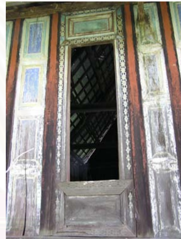
(บน)ภาพที่ 6-50 การเจาะช่องหน้าต่าง สัดส่วนยาวและประดับกรอบลูกฟักบน และล่าง ขอบหน้าต่างตกแต่งลวดลาย ดอกไม้เล็กๆมีกำนเชื่อมถึงกันคล้ายลาย ดอกประจำยามลูกโซ่
