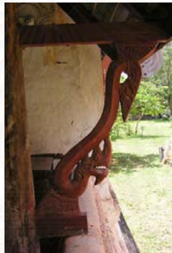
ภาพที่ 4-103 คันทวยหูช้างแบบเก่า ภาพที่ 4-104 คันทวยนาค รับ ภาพที่ 4-105 ส่วนคันทวยเก่าที่ถูก อิทธิพลจากภาคกลาง ฝีมือช่างท้องถิ่น ก่อผนังทับ
