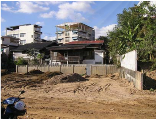
ภาพที่ 6-15 ชุมชนแออัดที่รุกล้ำแนววัดจากอดีตเข้ามาจับจองพื้นที่บริเวณมุมวัดทางทิศตะวันตกเฉียงใต้ถูกรื้อถอน เพื่อทำโครงการถนนสาธารณะริมแม่น้ำมูล
