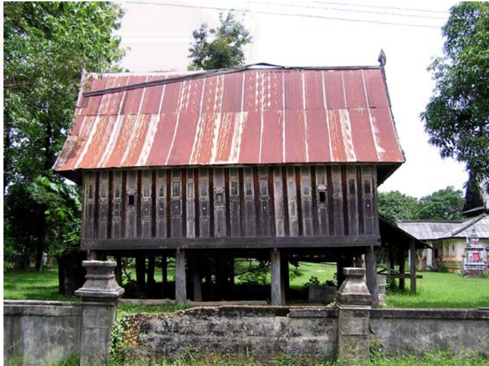
ภาพที่ 6-46 กุฏิไม้เฮือน 3 ห้อง ฝาผนังไม้ลูกฟักปะกนเจาะช่องหน้าต่าง เป็นช่องเล็กๆ เท่านั้น
