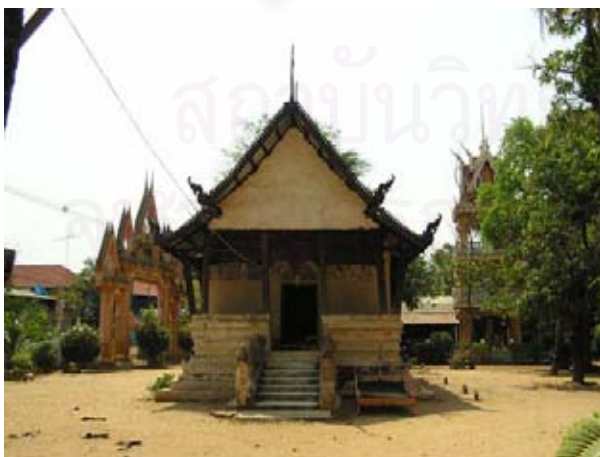
ภาพที่ 5-94 การก่อแท่นรารวะเบียงอมเสา ลุ่มวัดบ้านยางซ้า ซึ่งก่อเชื่อมเป็นเนื้อเดียวกับฐานอาคารขึ้นไปอมตีนเสา ทำให้อาคารดูเหมือนฐานอาคารสูง
