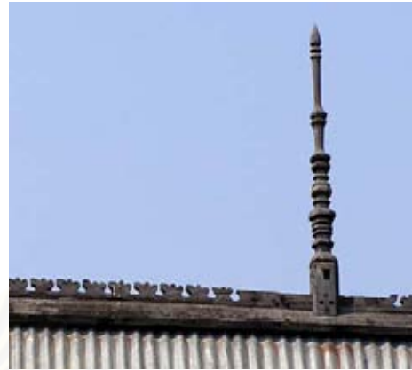
ภาพที่ 4-278 ช่อฟ้า(สัตบริภคท์)ไม้แกะทรงยอดแหลม ซ้อนชั้น และแกะใบวันแฉ่นเล็กประดับสันหลังคา
