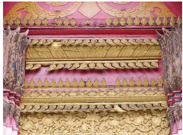
ภาพที่ 4-140 บริเวณใต้ช่อเหนือซึ้งผึ้ง มีการประดับไม้แกะลายบัวรวนอิทธิพลสถาปัตยกรรมล้านช้าง และประดับหน้ากระดานฐานพระติดกระจิงตามแบบสถาปัตยกรรมภาคกลาง
