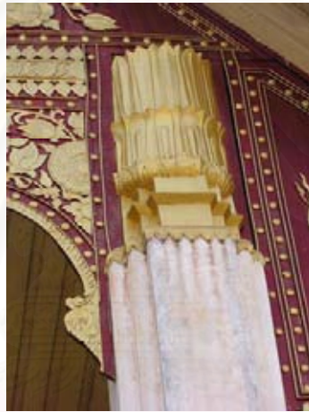
ภาพที่ 5-72 บัวหัวเสาทรงสูงซ้อน 2 ชั้น ลิมวัดธาตุดหลวงใต้ เมืองเวียงจันทน์
