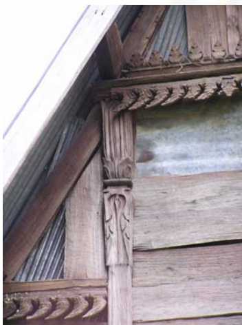
ภาพที่ 4-215 และ 4-216 บัวหัวเสาไม้แกะทรงผอมสูง และกาประดับกระจิงหน้ากระดานแบบภาคกลาง แต่เป็นฝีมือช่างท้องถิ่น
