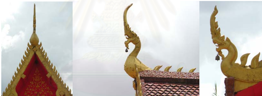
ภาพที่ 4-53 เครื่องลายอง โหง(ช่อฟ้า) และหางหงส์ ได้รับการบูรณะเป็นกระเบื้องเคลือบดินเผาเคลือบ(เซรามิค)
