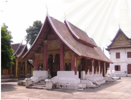
ภาพที่ 5-92 การก่อแท่นรารวะเบียงอมเสา อาฮามวัดคีลี เมืองหลวงพระบาง ถือเป็นเอกลักษณ์โดดเด่นของสถาปัตยกรรมล้านช้าง
