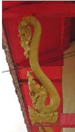
ภาพที่ 4-64 คันทวย นาคอิทธิพลภาคกลาง ฝีมือช่างท้องถิ่น
