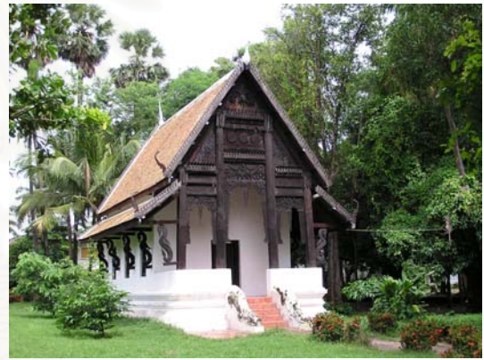
ภาพที่ 5-93 การก่อแท่นรารวะเบียงอมเสา ลุ่มวัดแจ้ง ถือเป็นเอกลักษณ์โดดเด่นของลุ่มอีสานที่รับอิทธิพลจากสถาปัตยกรรมล้านช้าง
