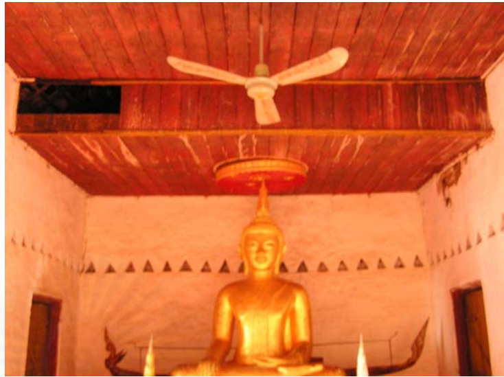
ภาพที่ 4-39 ฝาพาดานไม้ตีขีดลดระดับตามการลดชั้น หลังคาต้านนอกอาคาร
