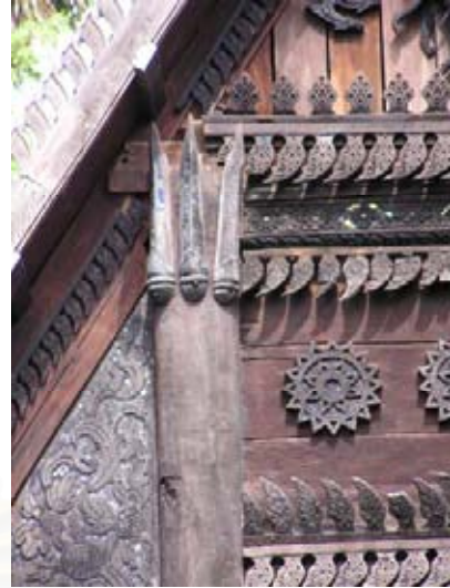
ภาพที่ 4-245 โครงสร้างหลังคามุขหน้า จั่วบน พาดผืนหลังคายาวเลยขอบเสาร่วมใน ไปทำชายคาที่เสาร่วมนอก ซึ่งแปลกตากว่าที่อื่น
