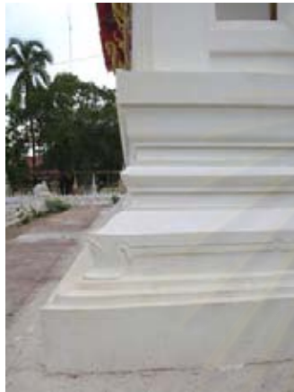
ภาพที่ 4-195 ฐานสิงห์แบบภาคกลาง สัดส่วน ผิดแปลกไปบ้าง เพราะเป็นฝีมือช่างท้องถิ่น
