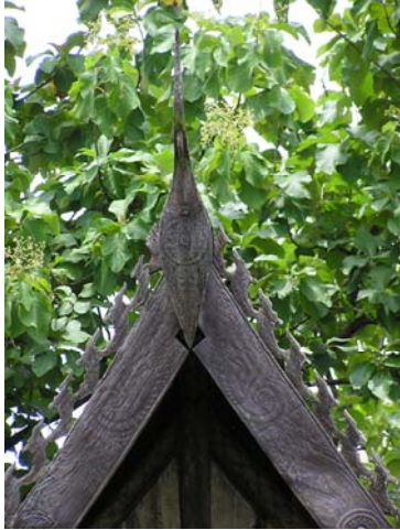
ภาพที่ 6-47 โหง้และแป้นลมไม้แกะสลัก รูปลายดอก กนกกำนชด สลับเกล็ดคนาค ฝีมือช่างท้องถิ่นแบบพื้นเมือง
