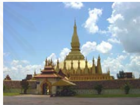
ภาพที่ 2-13 พระธาตุหลวง ปัจจุบัน ถูกบูรณะให้บัวเหลี่ยมเรียวขึ้นลักษณะคอขวด สะโอดสะองกว่าเดิม
