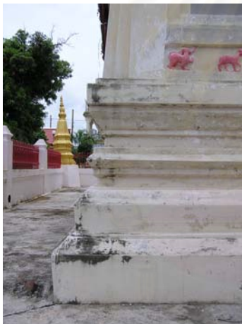
ภาพที่ 4-157 ฐานปัทม์บัวอกไก่ หน้ากระดานล่างซ้อน 2 ชั้น ฝีมือช่างท้องถิ่น
