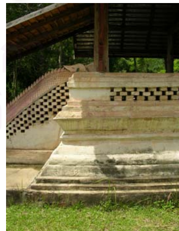
ภาพที่ 5-95 การก่อแท่นรารวะเบียงแบบโปร่ง ในลุ่มวัดหมากมี ฝีมือช่างท้องถิ่นที่ทำให้อาคารดูเบาขึ้น
