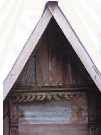
ภาพที่ 4-215 และ 4-216 บัวหัวเสาไม้แกะทรงผอมสูง และกาประดับกระจิงหน้ากระดานแบบภาคกลาง แต่เป็นฝีมือช่างท้องถิ่น
