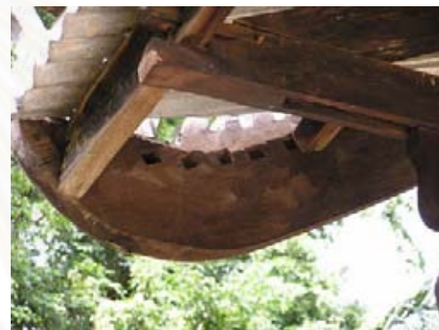
ภาพที่ 4-276 การติตรวระยะกา เข้ากับหลังคา ใช้การเข้าเดือยกับหัวไม้ระแนง ช่วยยึด
