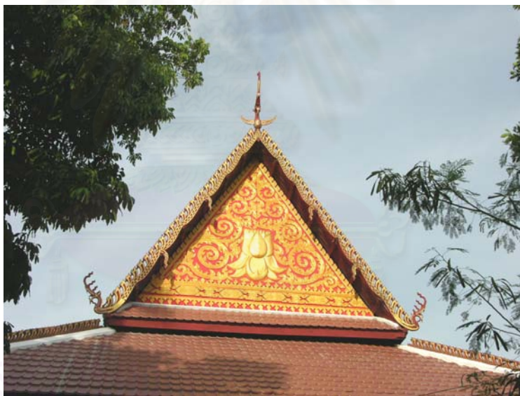
ภาพที่ 6-35 สีหน้า(หน้าบัน)หอแจกวัดศรีอุบลรัตนาราม เป็นลวดลายปูนปั้นลายเครือเถา อิทธิพลจากลวด สังเกตุส่วนหลังคามุงแผ่นเหล็ก ซึ่งเป็นการบูรณะยุคใหม่ แต่ทว่าทรงของหอแจกหลังนี้ยังคงงดงาม ได้สัดส่วน
