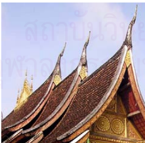
ภาพที่ 5-36 แป้นลมประดับอาสามวัดเชียงทอง เมืองหลวงพระบาง เห็นการปั้นขอบปูนอมกับไม้แป้นลม
