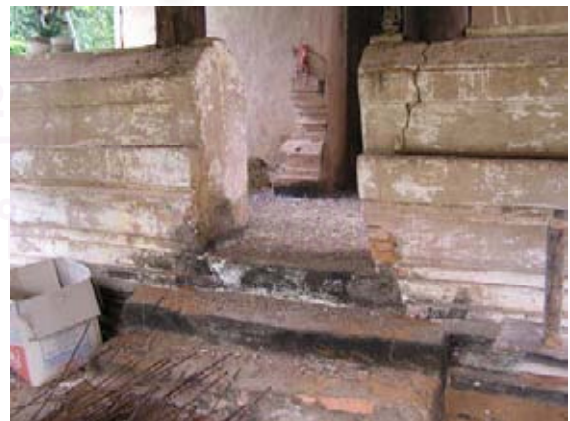
ภาพที่ 4-231 แท่นราวระเบียง เป็นระเบียงการสร้างจากสถาปัตยกรรมล้านช้าง และปั้นปูนเป็นบัวหลังเจียดตามแบบบัวภาคกลาง
