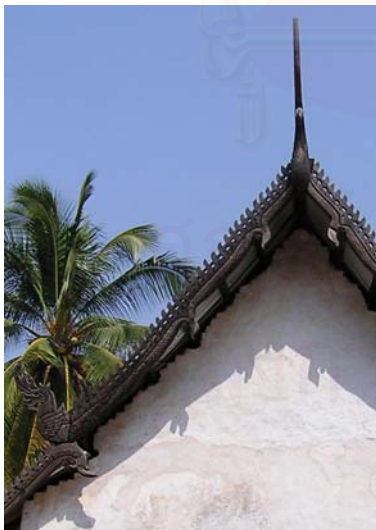
(ซ้าย-ขวา) เครื่องล่ายของไม้แกะสลัก รูปขนาดเกี่ยวกระหวัด ใช้องค์ประกอบ แบบภาคกลาง แต่ฝีมือสร้างสรรค์โดยช่างท้องถิ่น
