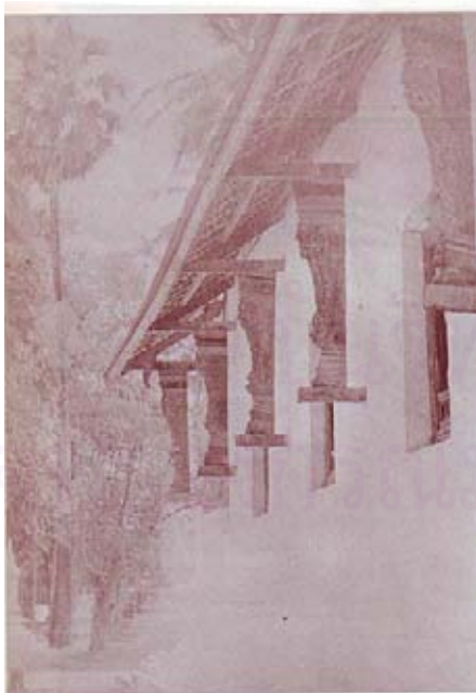
ภาพที่ 4-19 คันทวยแบบแผงหูช้างไม้แกะสลัก อย่างประณีต งดงาม ฝีมือช่างอีสานท้องถิ่น ที่มา: วิโรฒ ศรีสุโร, สิมอีสาน (กรุงเทพฯ: เมฆาเพรส, 2536), หน้า 40.
