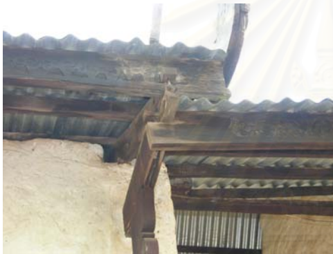
ภาพที่ 4-275 การจัดระดับชั้นลดหลังคา โดยใช้ เดือยปลายเต้า ยึดกับเชิงกลอน เป็นวิธีการที่ สร้างสรรค์โดยช่างท้องถิ่น(พระสงฆ์)
