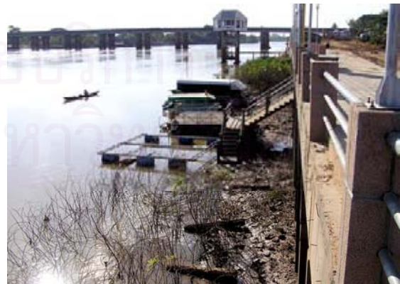
ภาพที่ 6-18 บริเวณตลิ่งทำน้ำมีบันไดค.ส.ล.ต่อลงไปยังโป๊ะ เป็นทางสัญจรทางน้ำที่เคยใช้มาตั้งแต่อดีต ปัจจุบันยังคงมีการใช้งานอยู่สำหรับชุมชนสองฝากฝั่งแม่น้ำมูล
