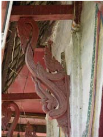
ภาพที่ 4-32 คันทวยนาค อิทธิพลจากภาคกลาง แต่สูงค่าด้วยการสร้างสรรค์จากช่างท้องถิ่น
