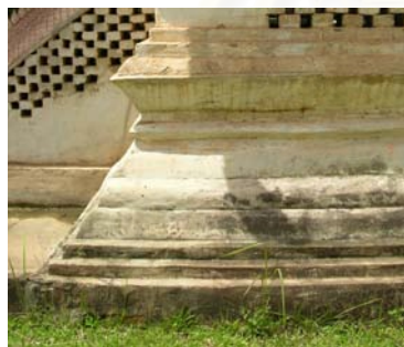
ภาพที่ 4-110 ฐานแฉวงชั้นบัวปากพานมุขด้านหน้า ภาพที่ 4-111 ฐานแฉวงชั้นบัวปากพานที่ห้องสังฆกรรม
