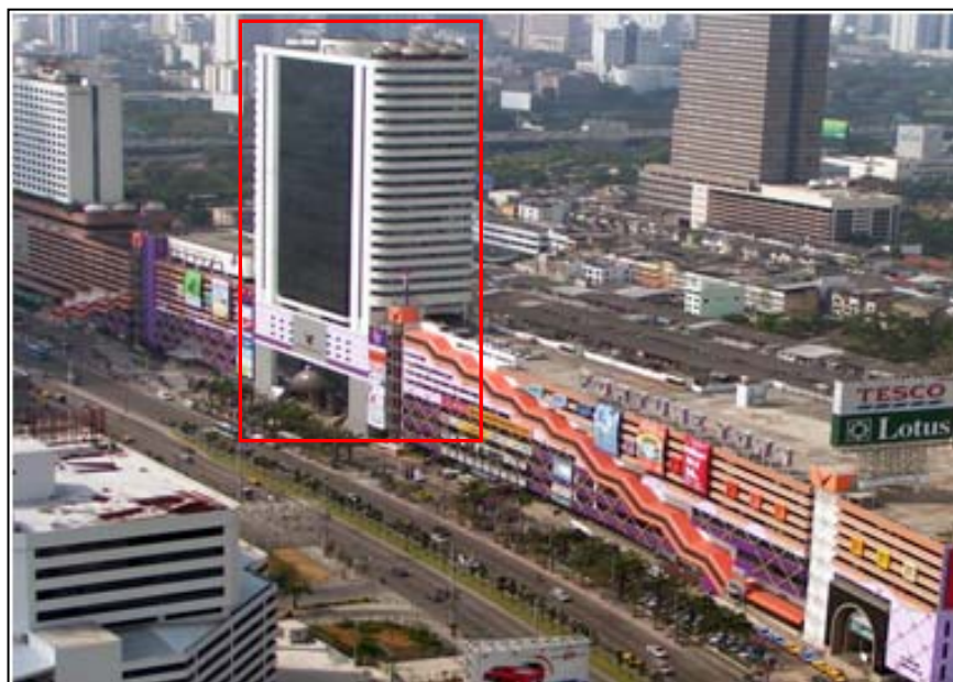
ภาพที่ 3.2 อาคาร ซี.พี.ทาวเวอร์ 2
