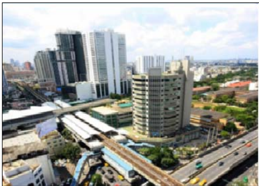
ภาพที่ 3.3 อาคาร ซี.พี.ทาวเวอร์ 3
