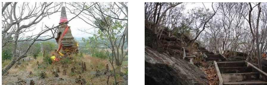
ภาพที่ 3-21 รูปถ่ายแสดงเจดีย์สมัยอยุธยาที่อยู่ในสภาพทรุดโทรมขาดป้ายสื่อความหมาย ภาพขวา บันไดทางเดินคอนกรีตขึ้นยอดเขาทำเทียมเป็นลักษณะภูเขาหินที่สูงชันแวดล้อมด้วยป่าโปร่ง (ที่มา : จากการสำรวจ พ.ศ.2554)
