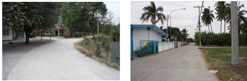
ภาพที่ 3-37 รูปซ้ายแสดงสภาพถนนซอยเจดีย์แปดเหลี่ยม รูปขวาแสดงสภาพกายภาพถนนทวารวดีพัฒนามุ่งหน้าไปยังโบราณสถานหมายเลข 3 ( ที่มา : จากการสำรวจ พ.ศ.2554)
