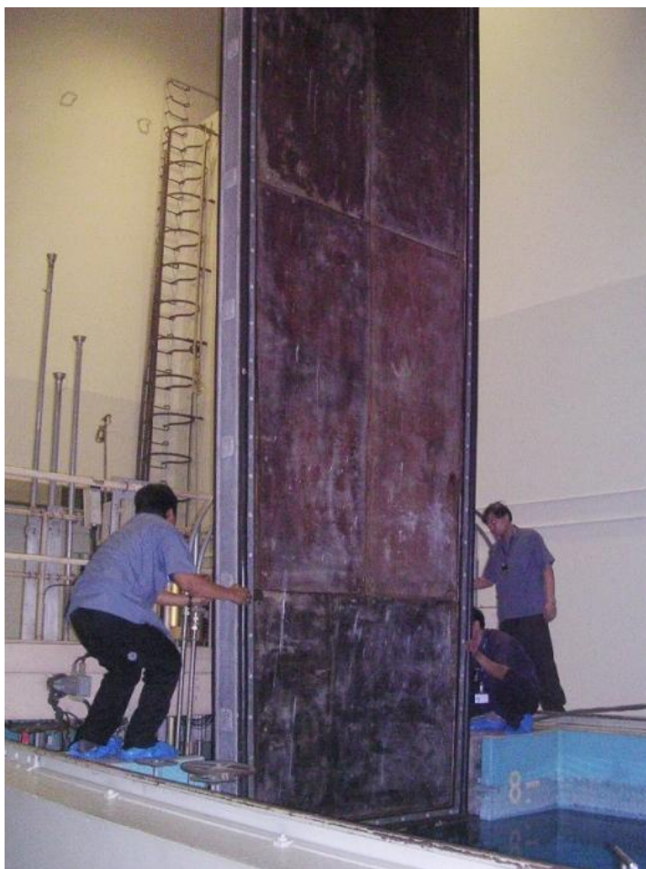
ภาพที่ 2.12 ประตูกั้นน้ำของเครื่องปฏิกรณ์ปรมาณูวิจัย (ปปรว1/1)
