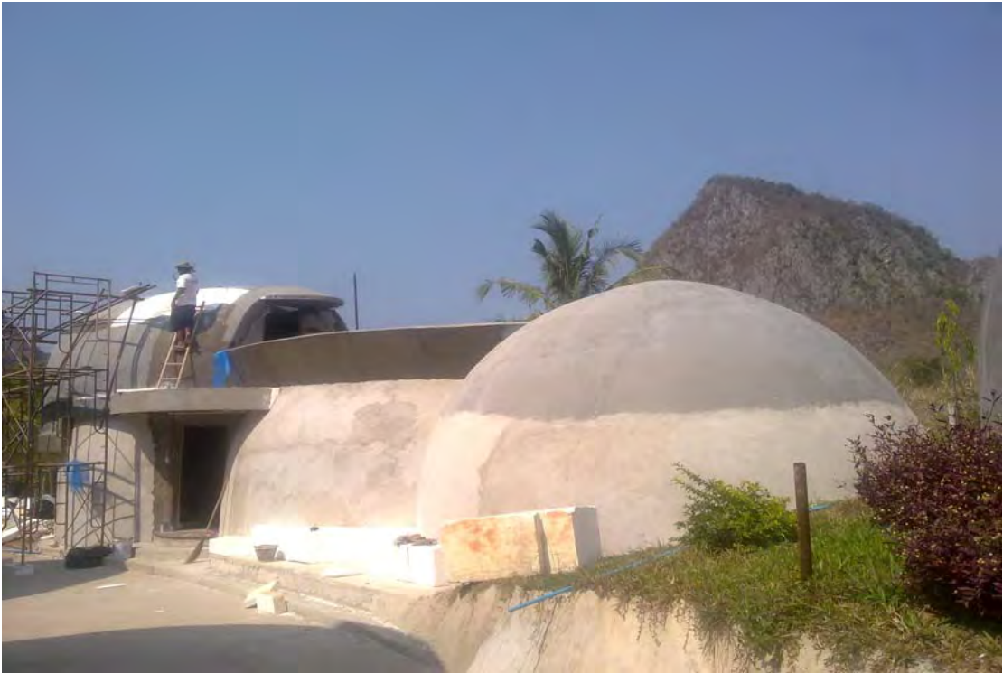
ภาพที่ 4-26 โครงสร้างอาคารแล้วเสร็จ 100%
