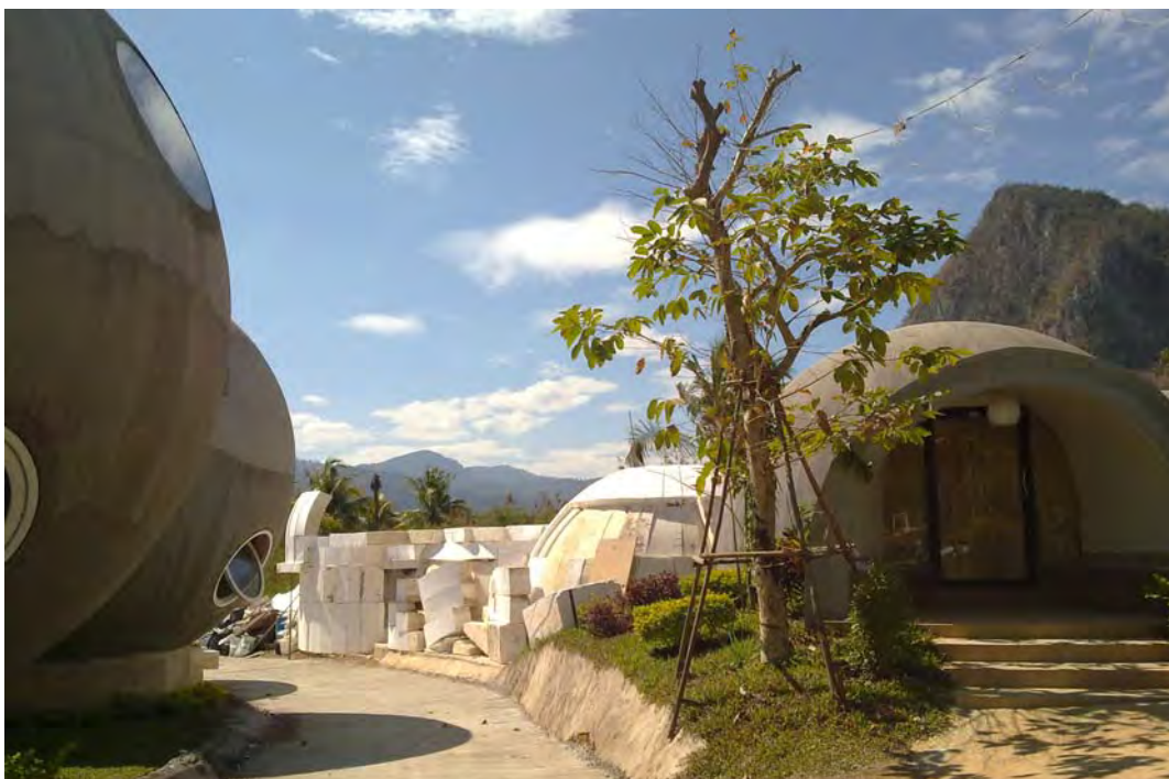
ภาพที่ 4-23 โครงสร้างอาคารประมาณ 50%
