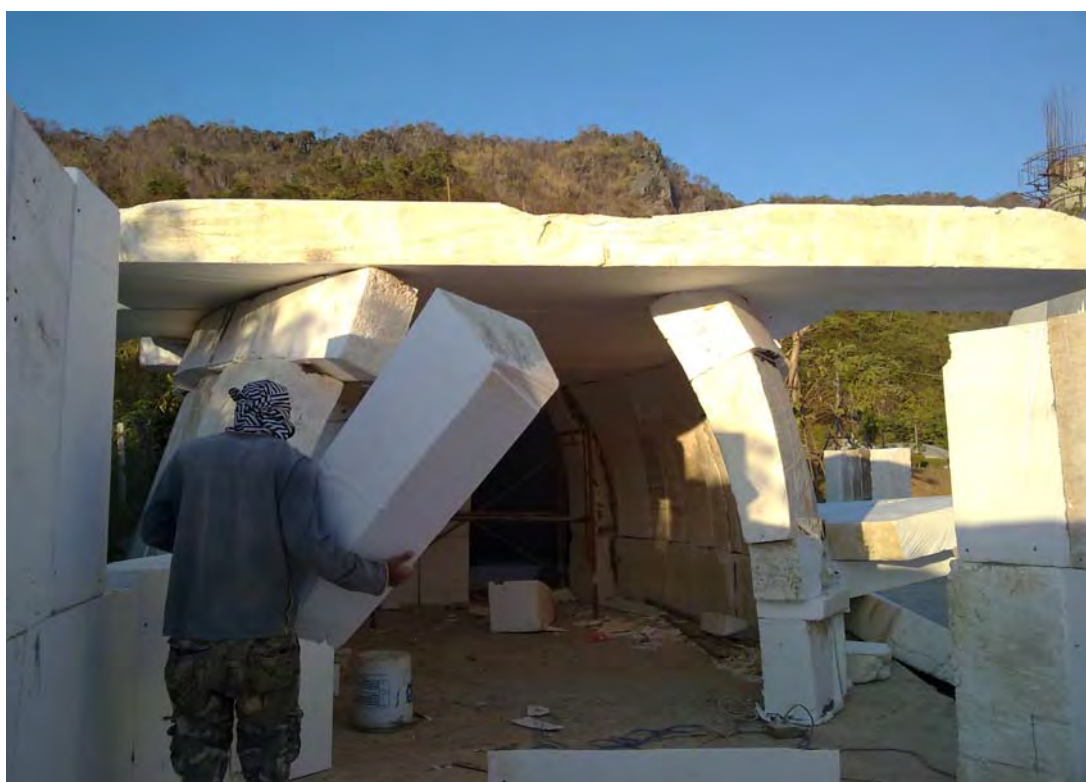
ภาพที่ 4-21 วางพื้นหลังคาบนโครงสร้างผนังรับน้ำหนัก
