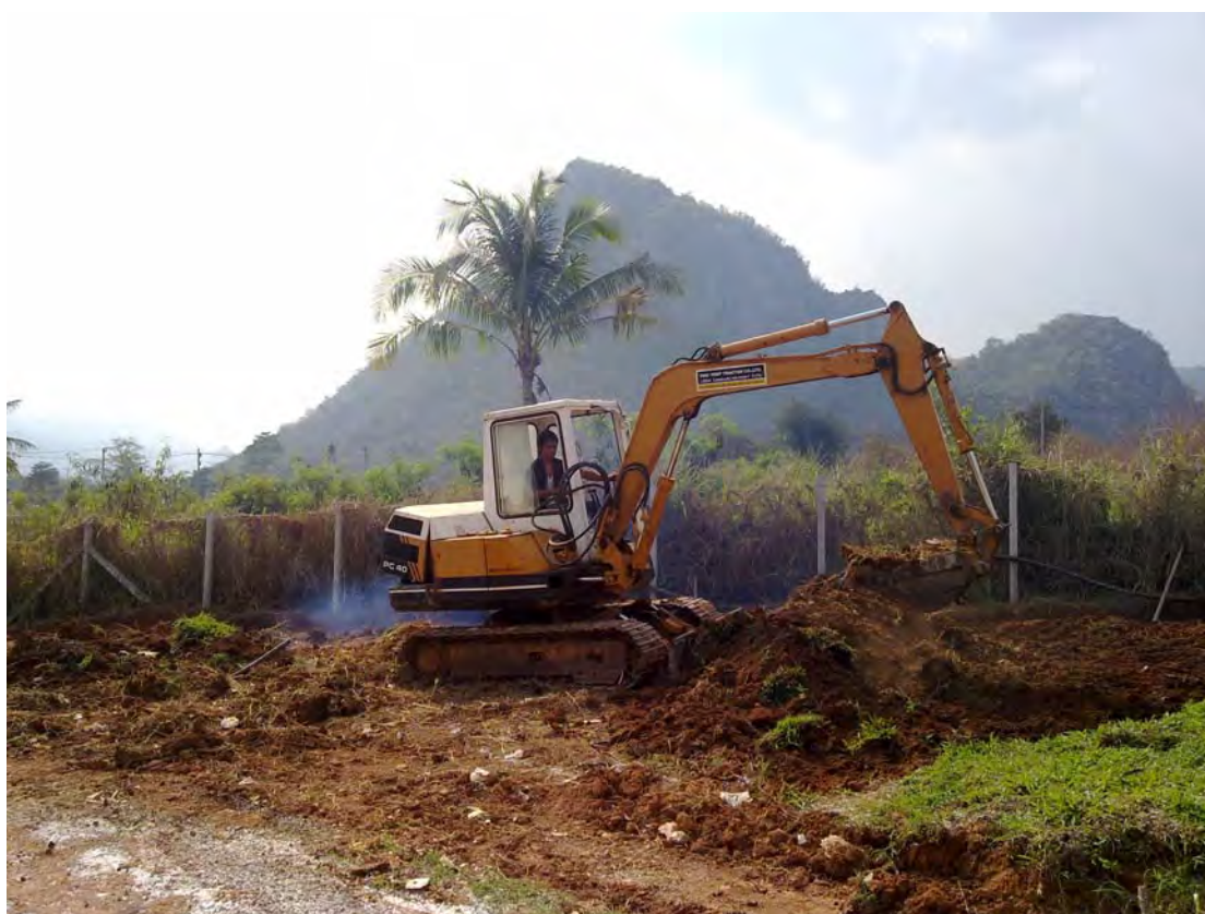
ภาพที่ 4-11 ปรับสภาพพื้นที่ก่อสร้าง
