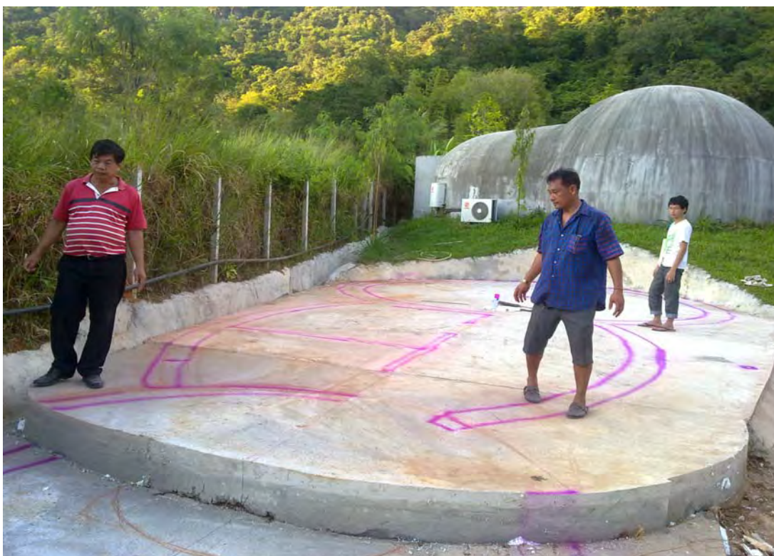
ภาพที่ 4-13 อาจารย์ที่ปรึกษาตรวจสอบผังและแนวทางการนำความเย็นขึ้นสู่อาคาร
