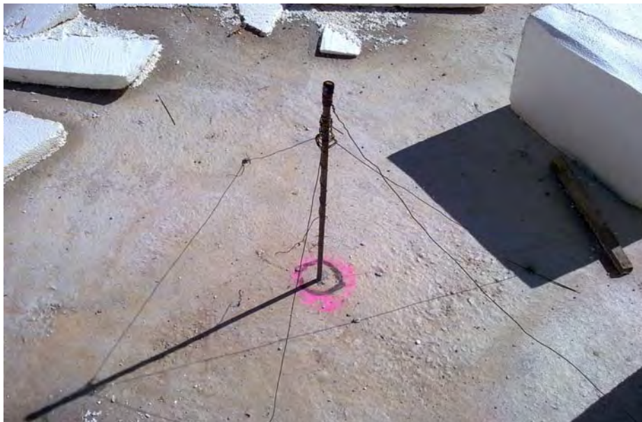
ภาพที่ 4-18 จุดอ้างอิงสำหรับสร้างผนังโค้ง
