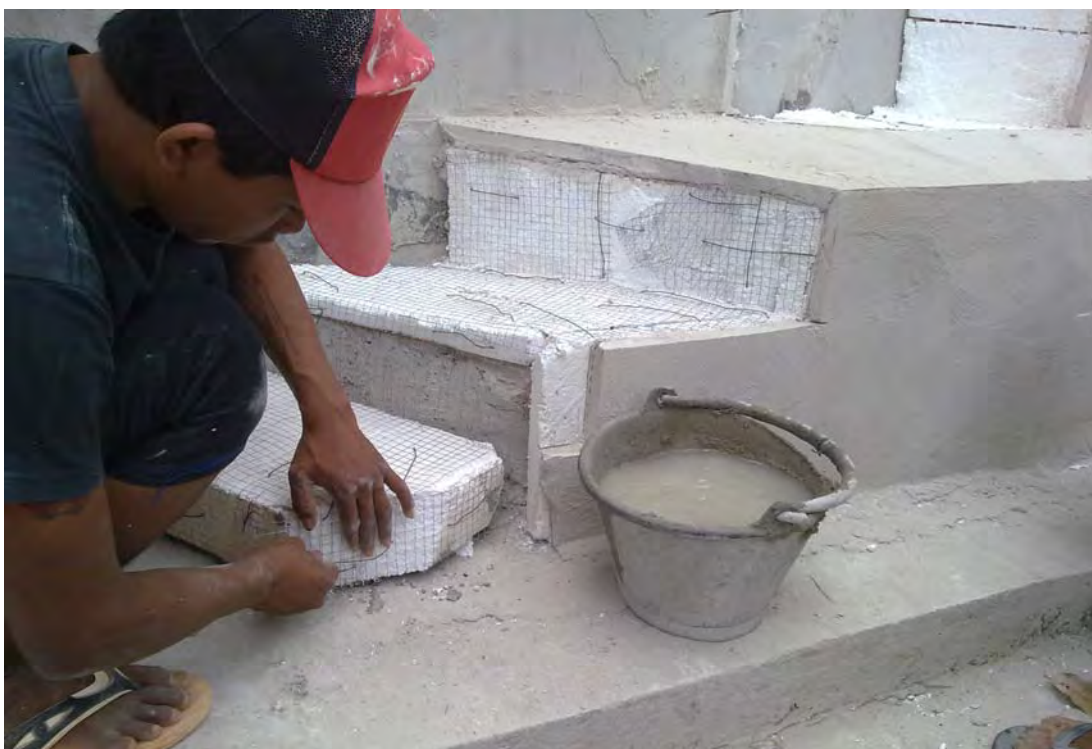
ภาพที่ 4-24 การเก็บรายละเอียดจุดเสี่ยงการนำความร้อนเข้าสู่อาคาร
