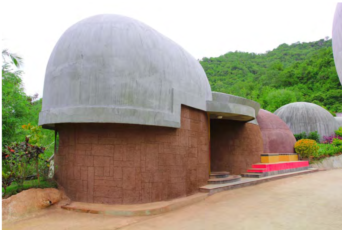
ภาพที่ 4-35 ทักษะถ่ายภาพภายนอก ด้านทิศใต้
