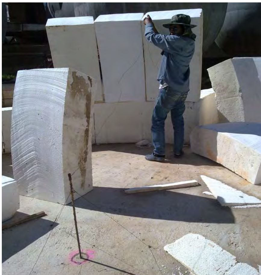
ภาพที่ 4-19 การติดตั้งสำหรับโครงสร้างผนังโค้ง
