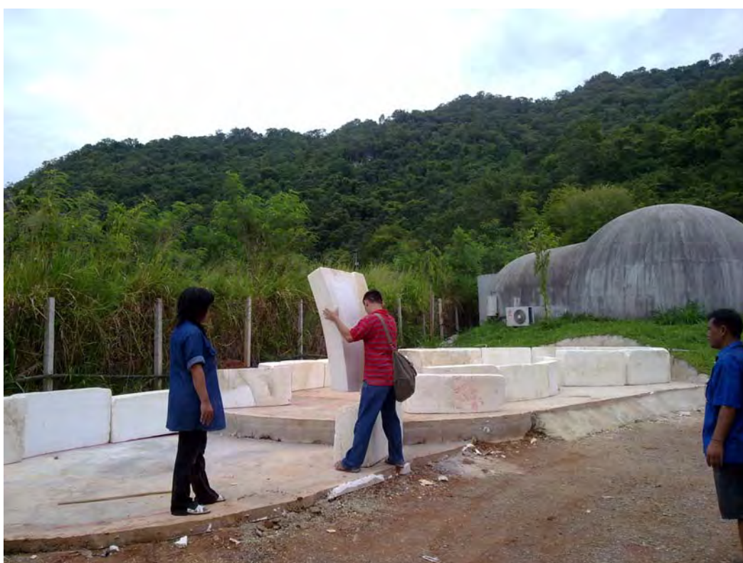
ภาพที่ 4-17 การเริ่มต้นประกอบฐานและติดตั้งผนังอาคาร
