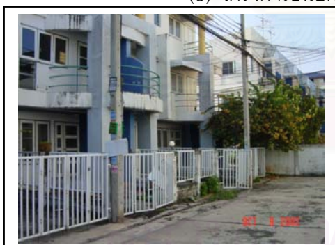
ภาพที่ 3.9 สภาพบ้านไม่มีผู้อยู่อาศัยในโครงการฯ
